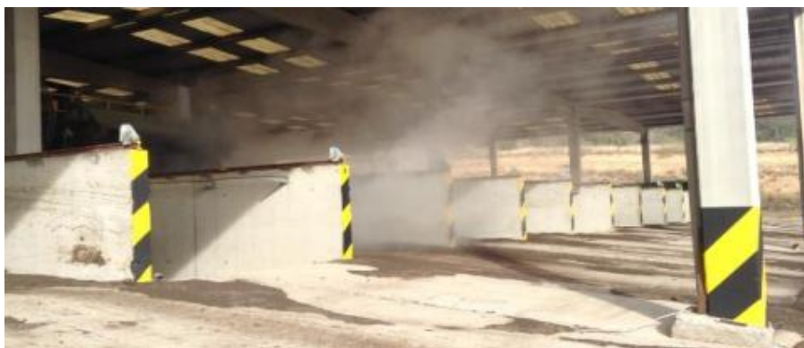
Canals de compostatge de llots de Calles
