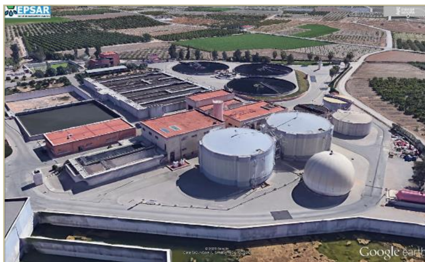
Instal·lació de digestió de llots de depuradora i subproductes industrials en l'EDAR Alzira-Carcaixent
