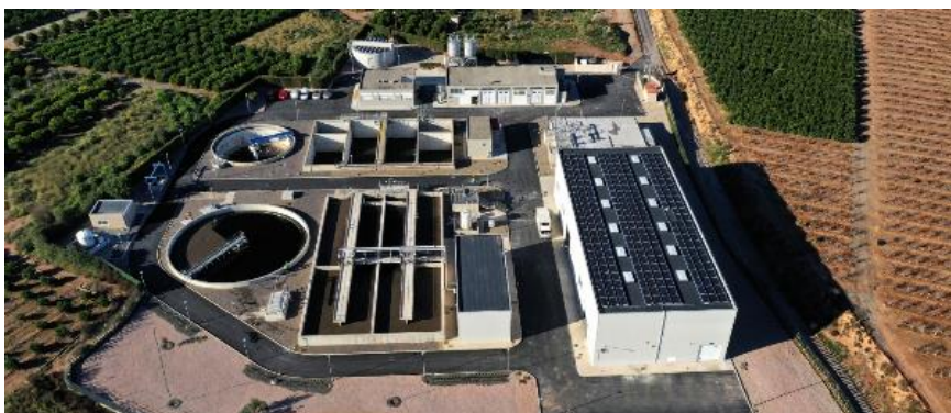
EDAR Bétera. Instal·lació de plaques solars en coberta de l'edifici de pretractament
