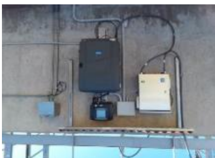
EDAR Alcalà de Xivert (Alcossebre). Automatització del dosatge de coagulant per a la desfostació
