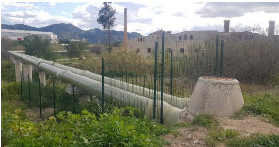
Canals. Obres de substitució dels trams aeris
