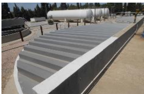
EDAR Quart - Benáger. Substitució de cobertes dels espesadores
