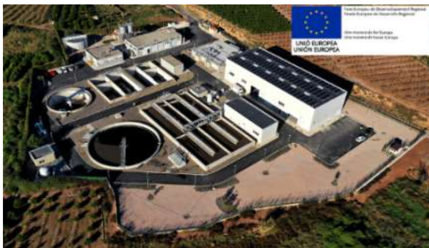
Bétera. Obres d'ampliació
