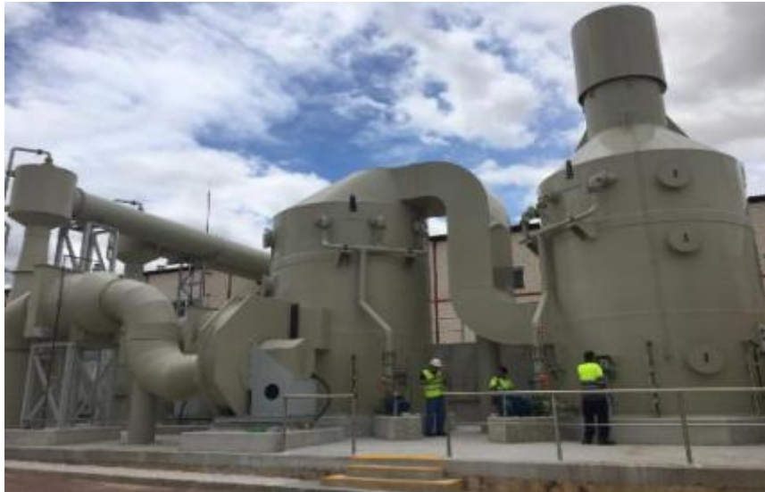
Aspe. Reparació d'instal·lacions de desodoració
