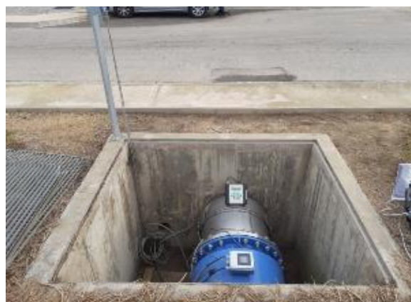
Treballs de control: treballs de verificació "in situ" de bàscules de pesatge i cabalímetres
