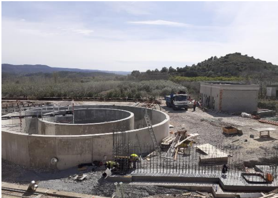
Jarafuel. Obres de reforma
