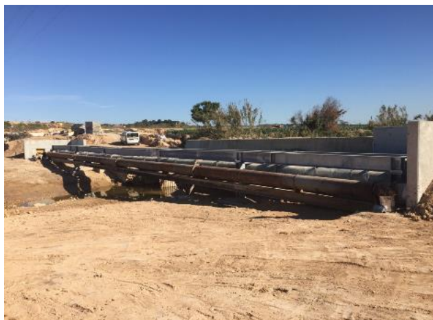
Pilar de la Horadada. Obra d'emergència
