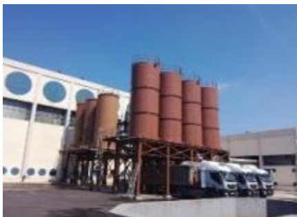
EDAR Pinedo. Ampliació del sistema d'emmagatzematge de llots deshidratats
