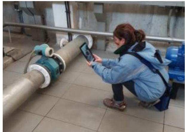
Trabajos de control: fotografía termográfica del funcionamiento de los equipos - verificación de caudalímetros
