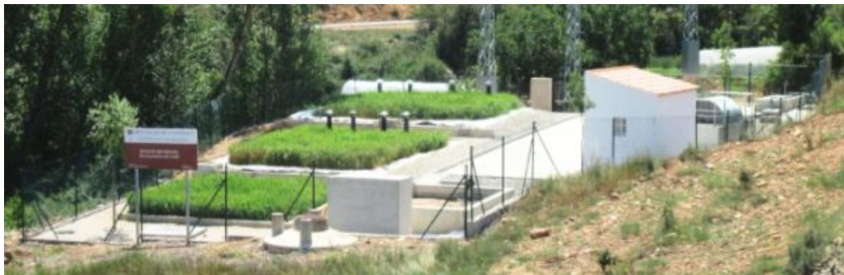
EDAR Vilanova de la Reina. Vista general.
