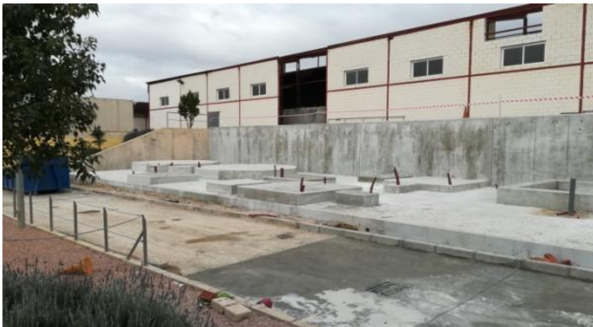
Aspe. Reparació desodoració
