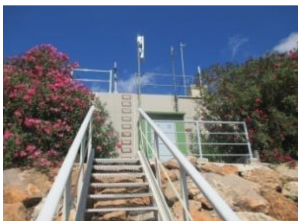
ETAP Sagunt. Millora d'accés als depòsits
