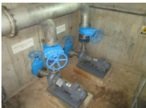
EDAR Camp de Túria II. Substitució de vàlvules de tall de la recirculació de llots
