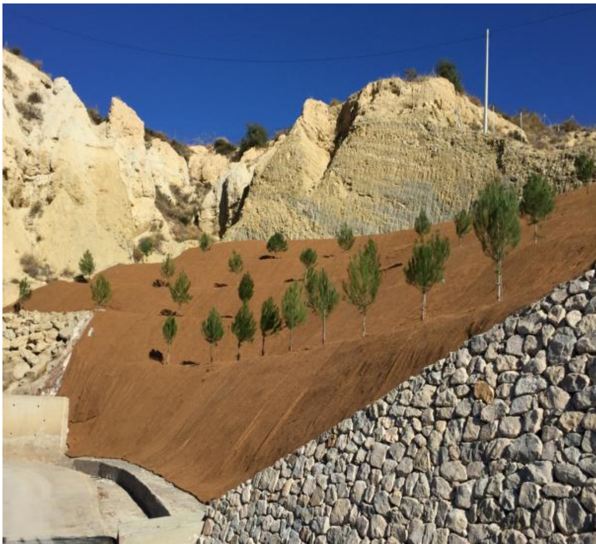
Xixona. Reposició de talussos
