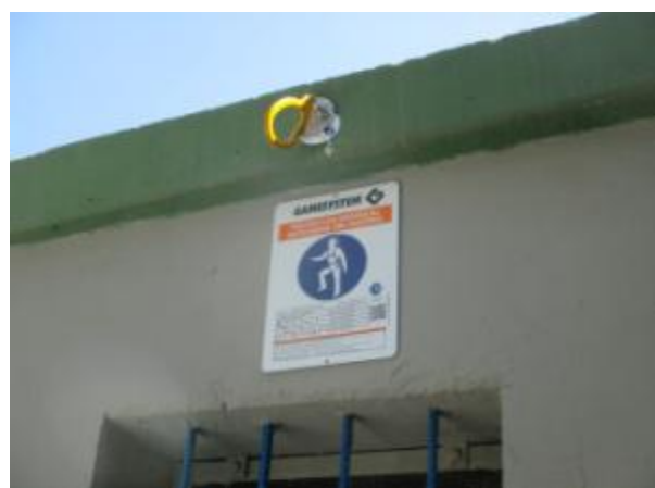
ETAP Sagunt. Instal·lació de sistema de protecció anticaiguda
