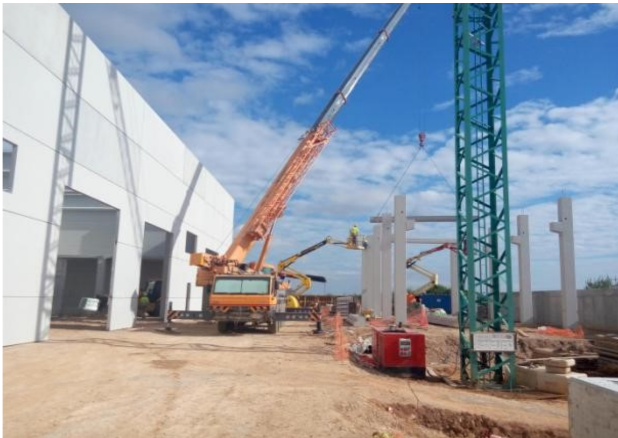
Bétera. Reforma EDAR
