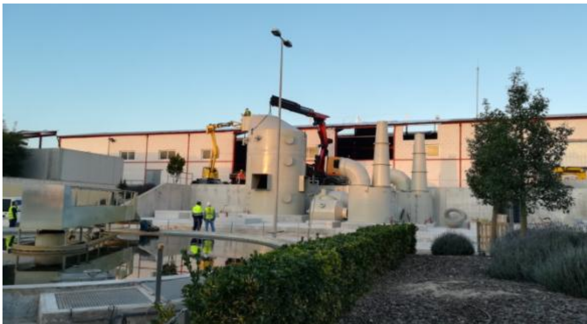
Aspe. Reparació desodoració
