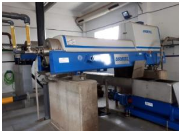
EDAR Pobla de Farnals. Instal·lació de nou centrífuga per a la deshidratació de llots
