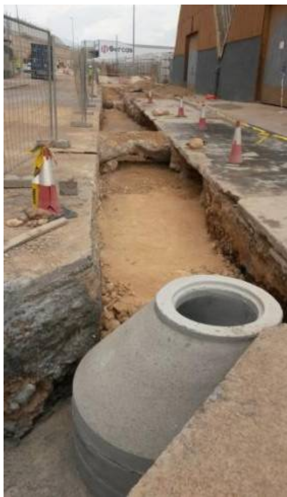
Onda. Reparació col·lector general
