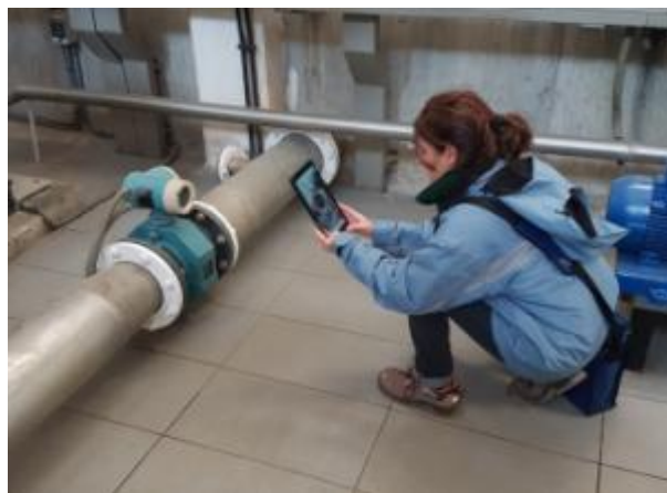
Treballs de control: fotografia tomogràfica del funcionament dels equips - verificació de cabalímetres
