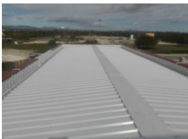
EDAR Alzira - Carcaixent. Substitució de cobertes metàl·liques
