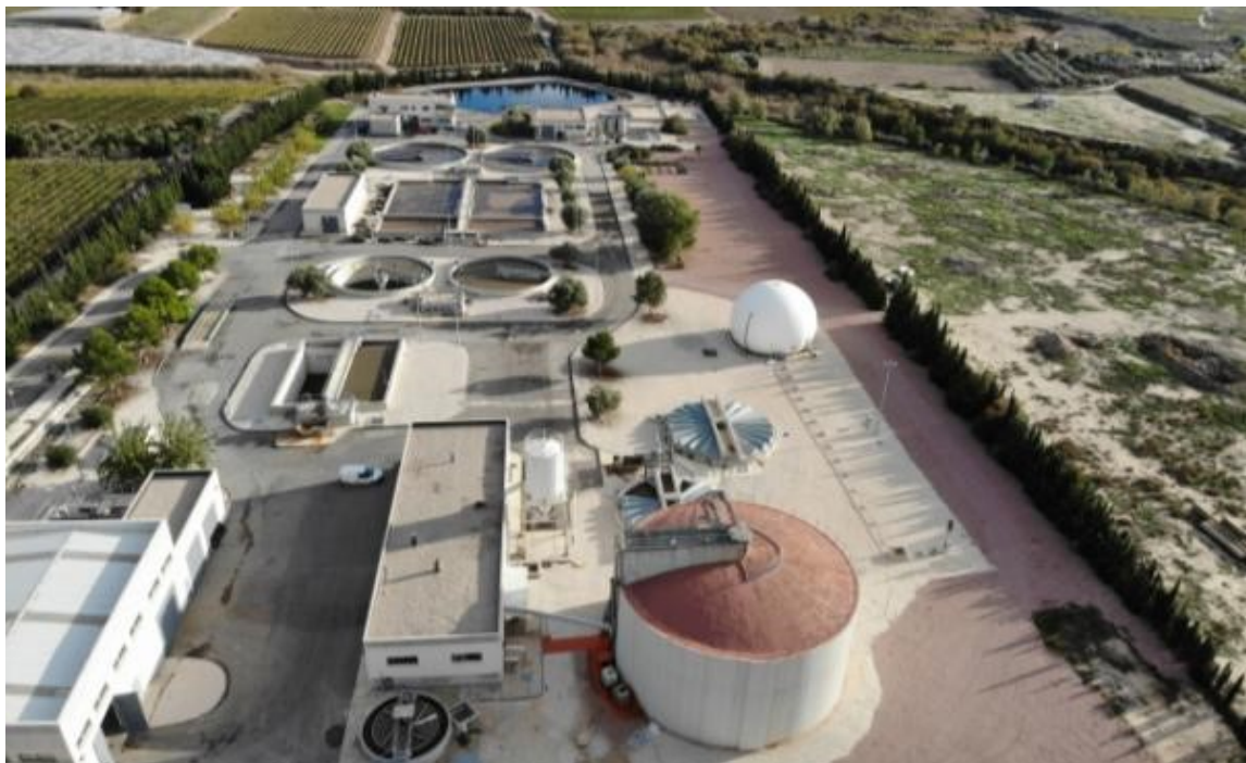
EDAR Novelda – Monforte del Cid. Vista general.
