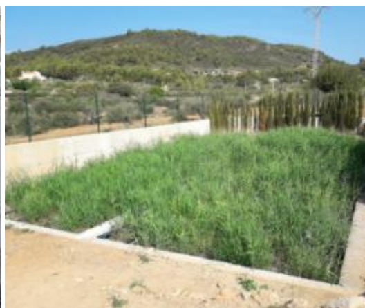
EDAR La Foia de l'Alcora. Terciari mitjançant aigües submergides de flux vertical
