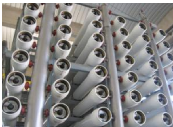
IRAD Benidorm. Membranes d'osmosi inversa
