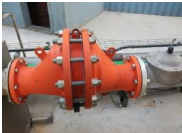
EDAR Pinedo 1. Instal·lació de apagaflama en la línia de gas
