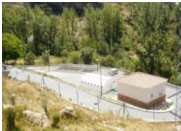
EDAR Gaibiel. Vista general
