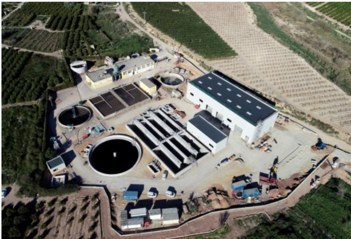
Bétera. Reforma EDAR
