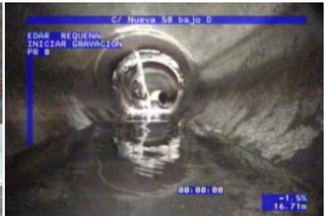
Imagen del interior del colector, tomada por el robot de inspección
