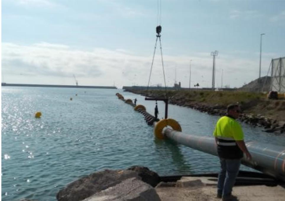
Obras de emergencia para la reparación del emisario submarino de Oropesa
