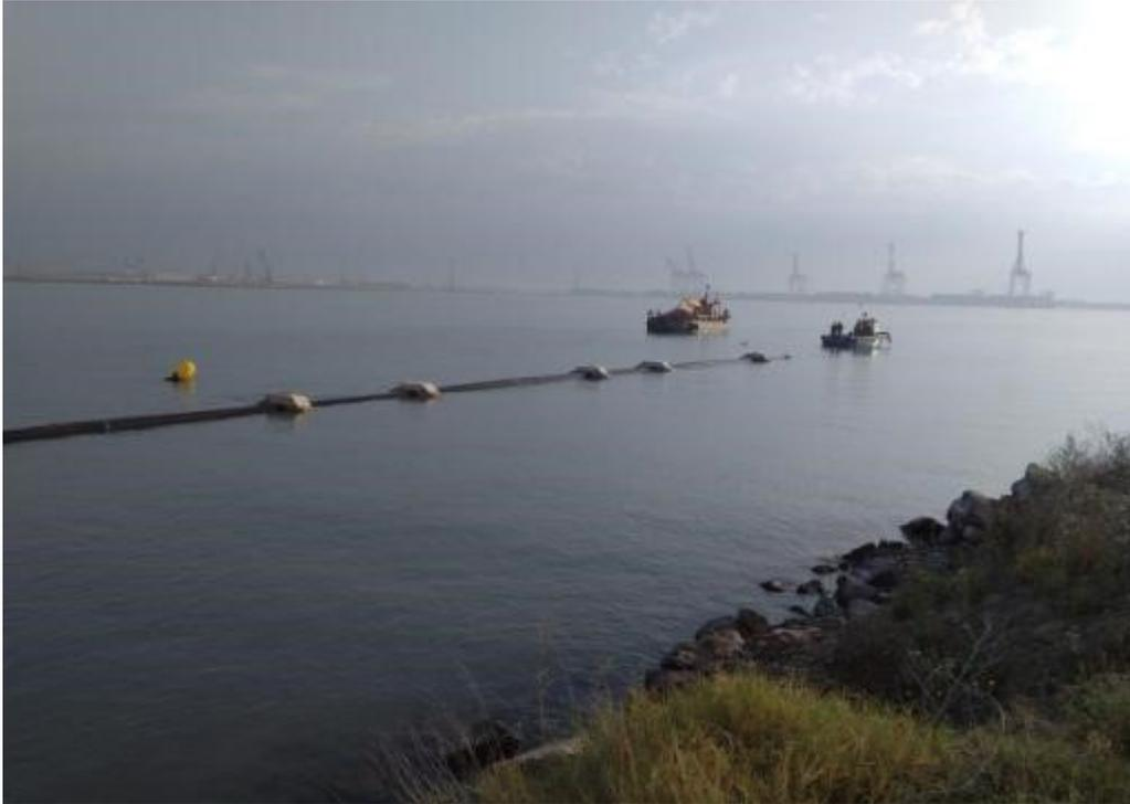
Obras de emergencia para la reparación del emisario submarino de Benicàssim
