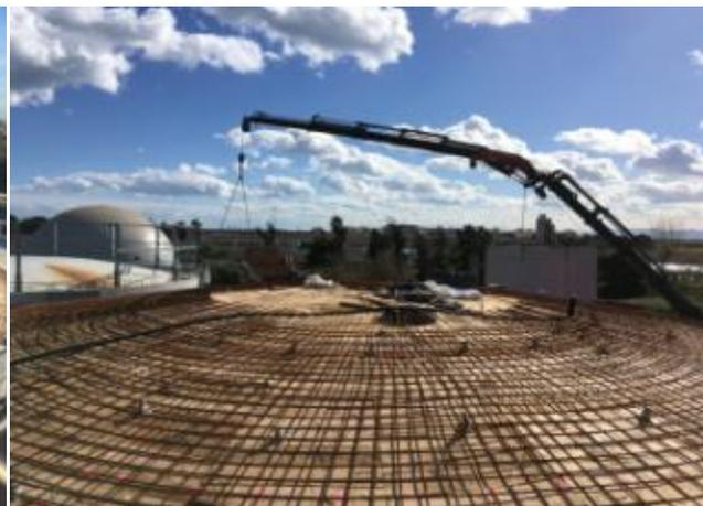
2. Reconstrucción cúpula EDAR Pinedo. Encofrado
