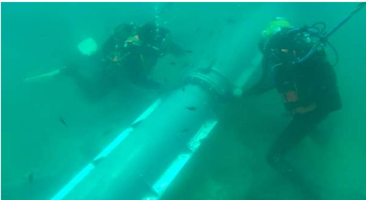
Obras de emergencia para la reparación del emisario submarino de Torreblanca
