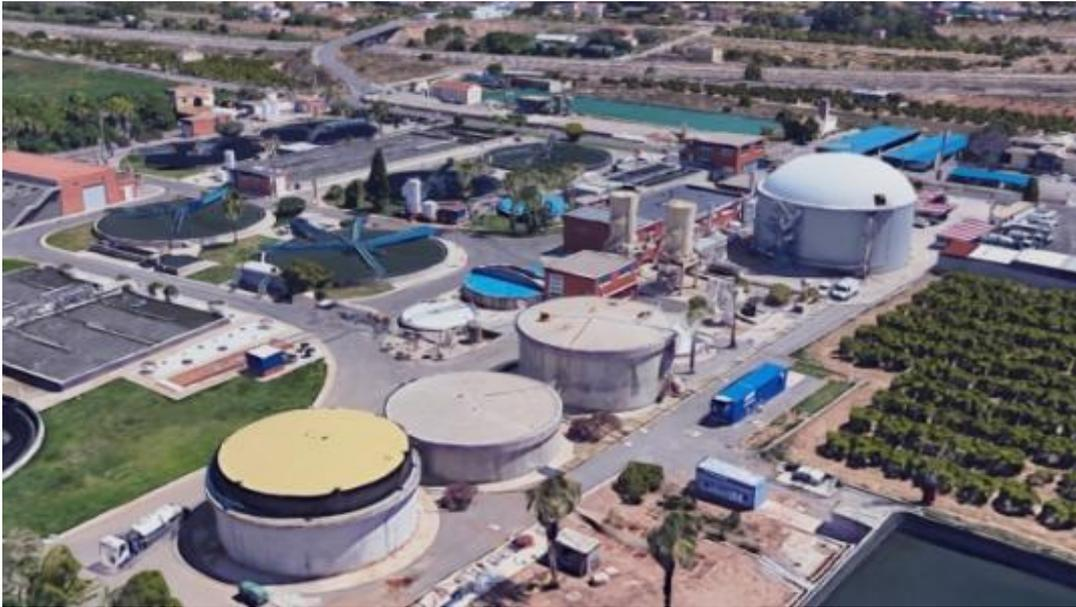
Instalación de digestión de lodos de depuradora y subproductos industriales en la EDAR de Castellón de la Plana
