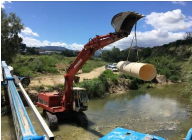
Obras de emergencia para el restablecimiento del colector general del tramo 2 del Sistema Font de la Pedra
