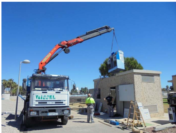
EDAR Quart - Benáger. Sustitución celdas transformador
