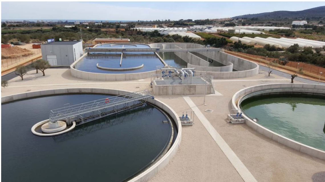
Nueva EDAR de Peñíscola
