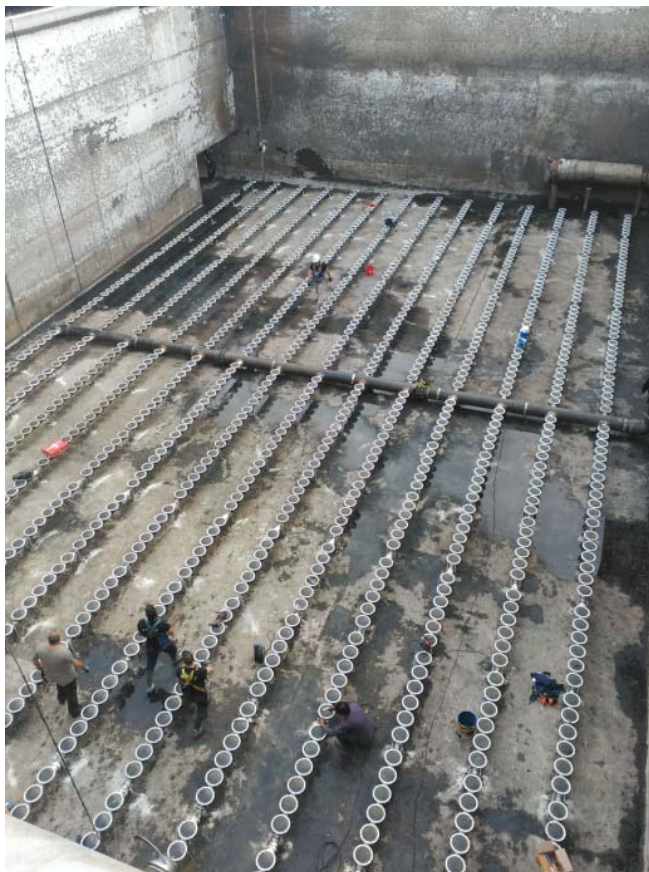
EDAR Pinedo 2. Sustitución de parrillas de difusores de aire en el tratamiento biológico
