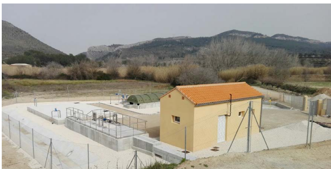
Nueva EDAR de Bellús
