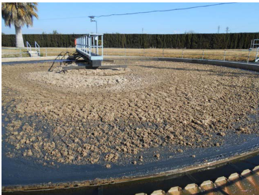
Efectos de un vertido de industria química sobre la EDAR de Chiva
