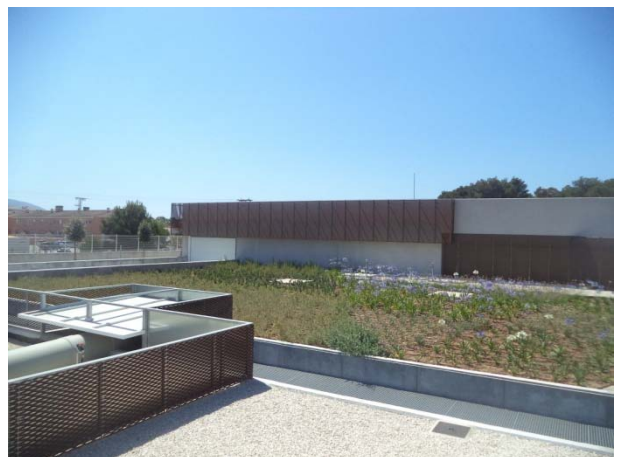
EDAR Teulada - Moraira. Vista General
