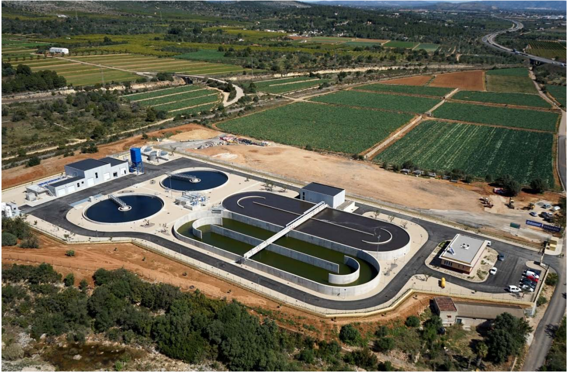
Nueva EDAR de Peñíscola
