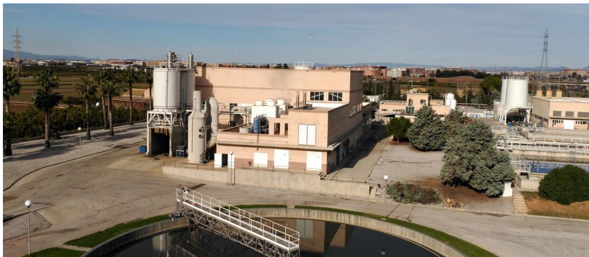
Secado térmico de lodos de Quart - Benáger
