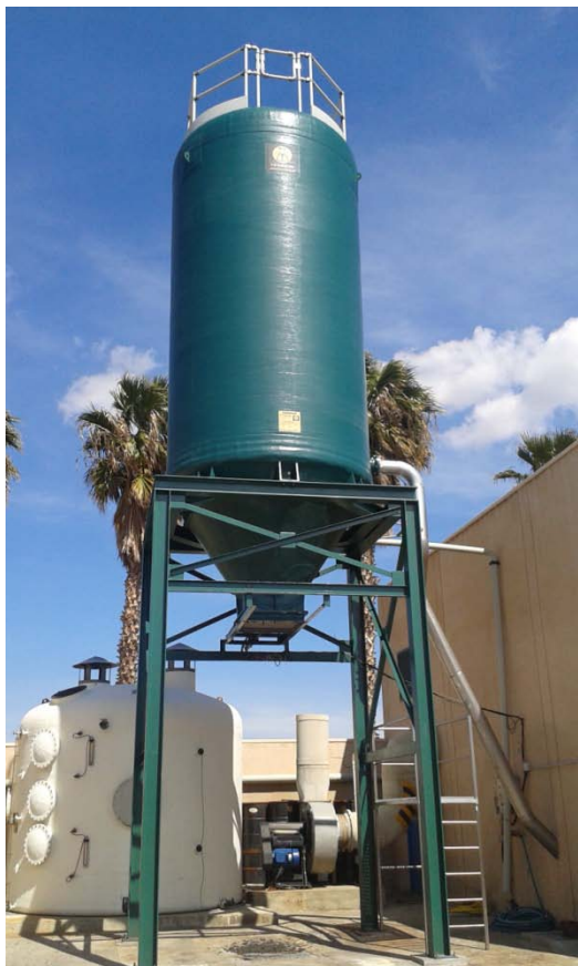
EDAR Callosa del Segura. Nueva tolva de lodos deshidratados
