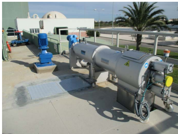
EDAR Pobla de Farnals. Instalación de nuevo tamiz de fangos primarios
