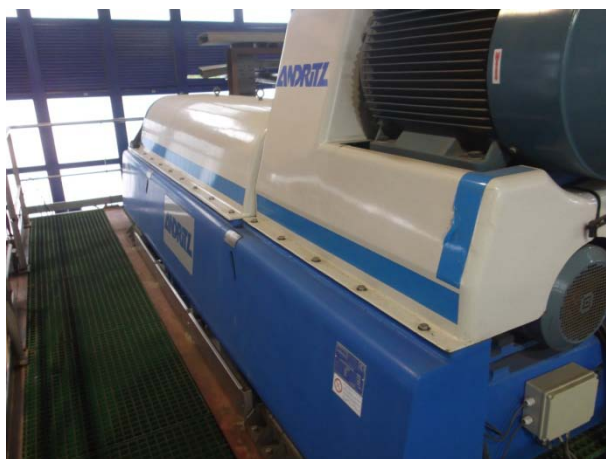
EDAR Pinedo. Sustitución de decantadores centrífugos de deshidratación
