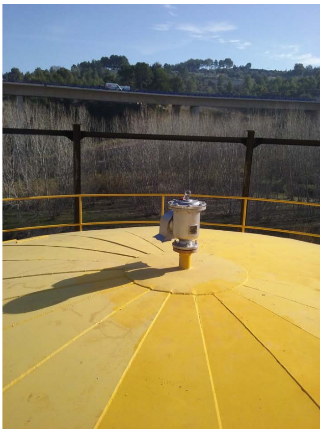
EBAR Alcoy. Instalación válvula de sobrepresión en gasómetro
