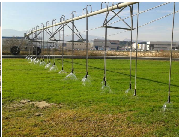
EDAR Valle del Vinalopó. Infiltración - percolación
