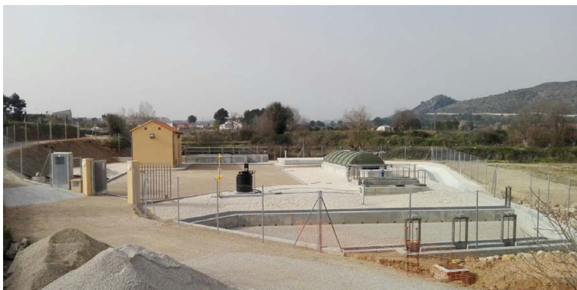
Nueva EDAR de Bellús
