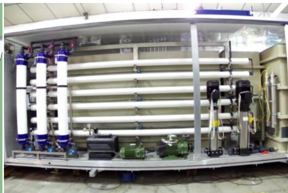
Planta piloto en fase de construcción
