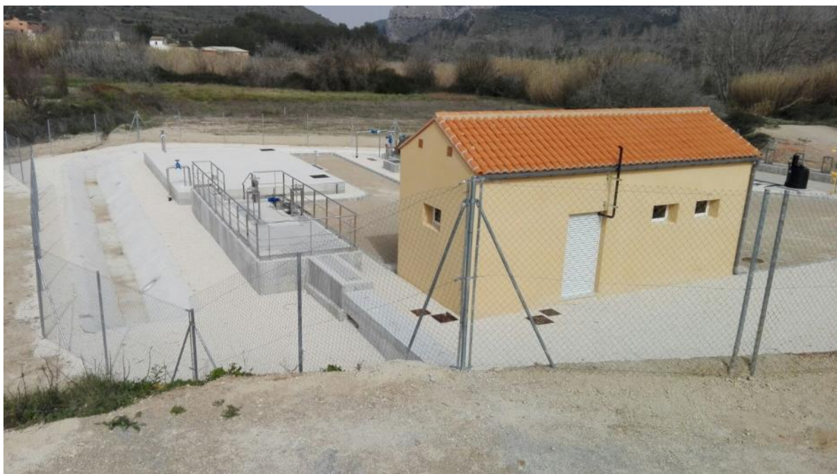
Nueva EDAR de Bellús
