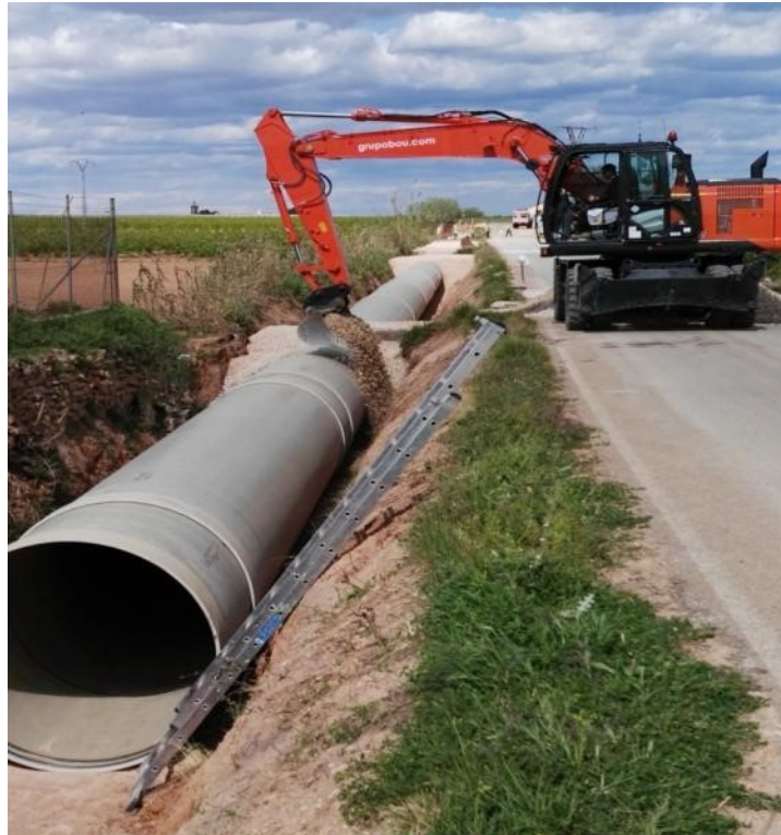
Recubrimiento de la acequia de Sollana
