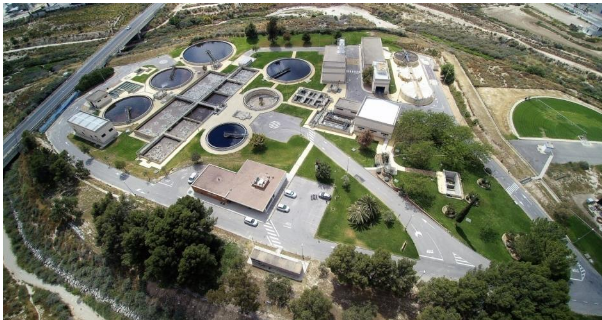
EDAR Valle del Vinalopó. Vista general.
