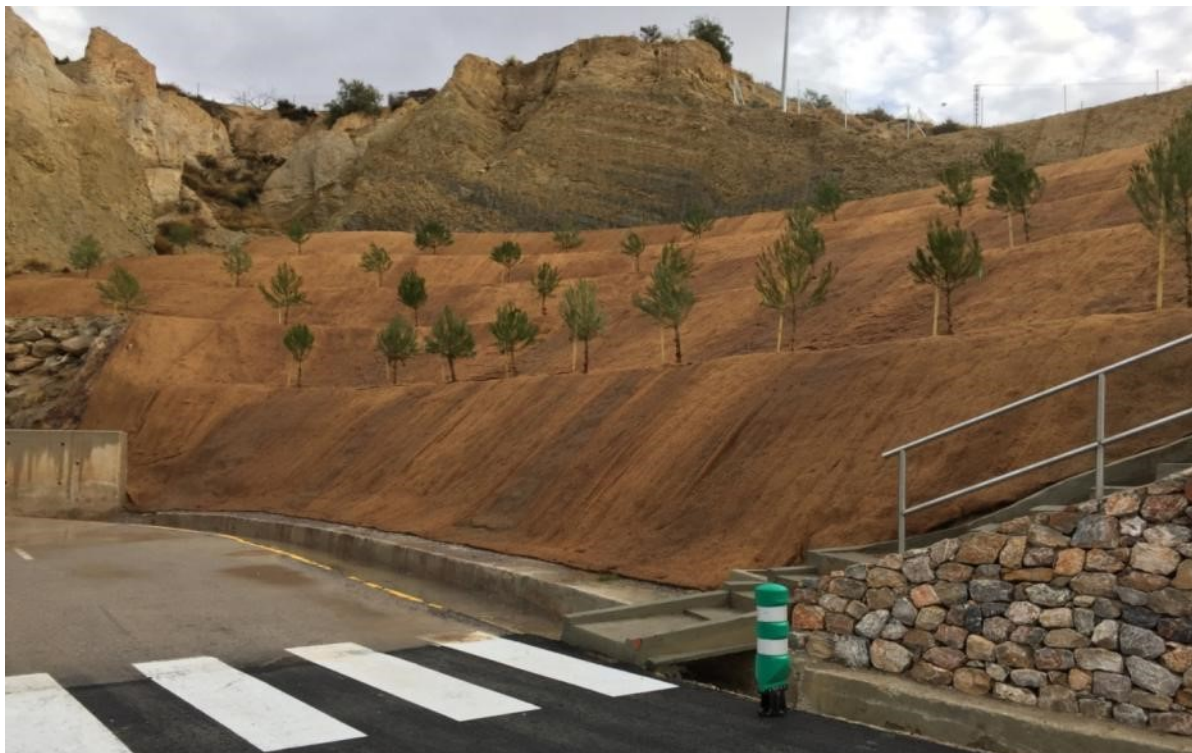
Reparación taludes EDAR Xixona
