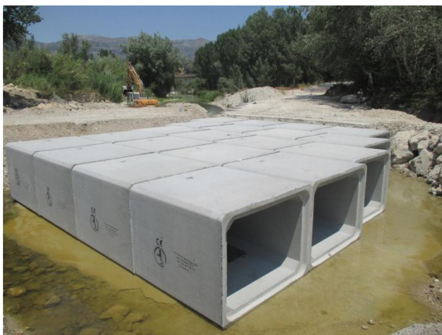
Obras de emergencia de la EDAR de Font de la Pedra (Muro de Alcoi)
