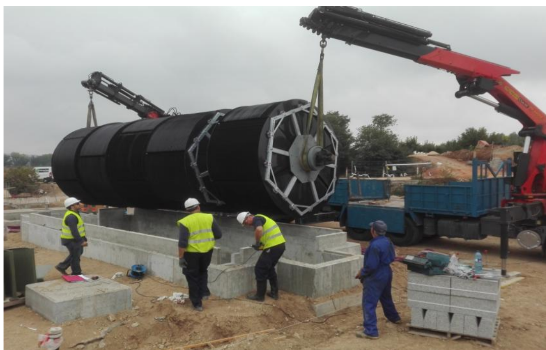
Nueva EDAR de Bellús
