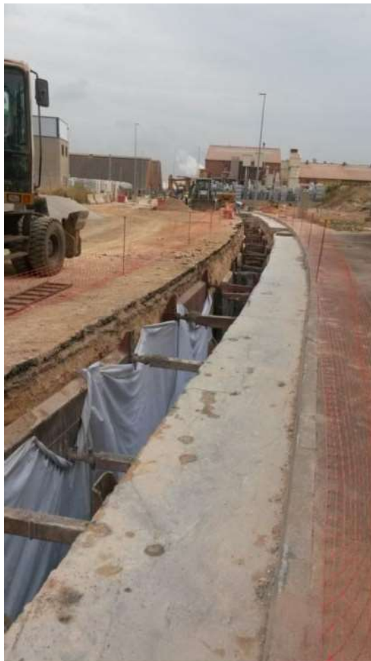
Obras reparación colector general Onda
