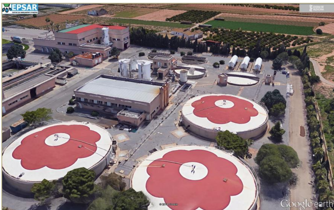
Digestores de la EDAR Quart Benàger donde se realiza la codigestión de subproductos
