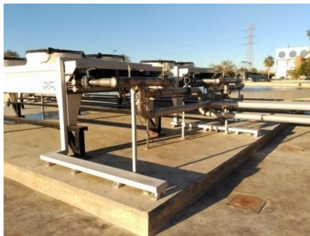
EDAR Pinedo 1. Sustitución aeroveniladores
