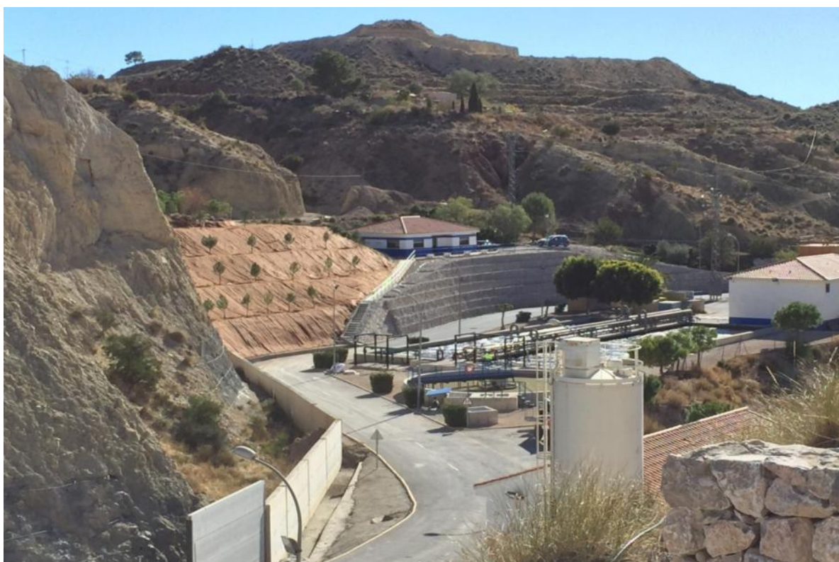
Reparación taludes EDAR Xixona
