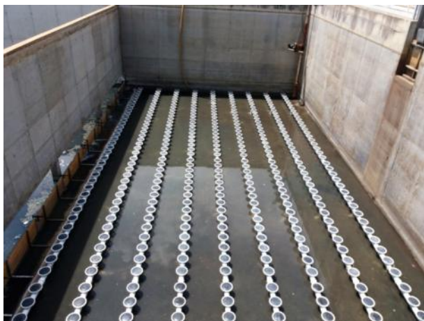
EDAR Quart - Benáger. Instalación de difusores en cámaras anóxicas
