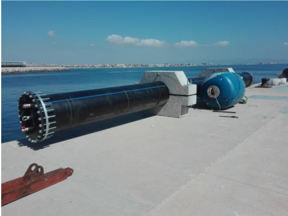
Obras de emergencia reparación emisario Vera (Valencia)
