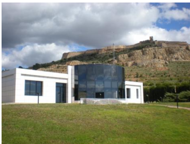
ETAP Sagunto. Edificio de control
