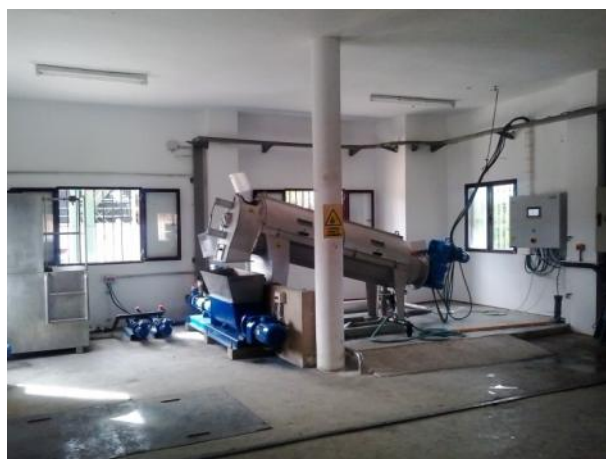
EDAR Pego. Suministro de nuevo tornillo deshidratador de lodos
