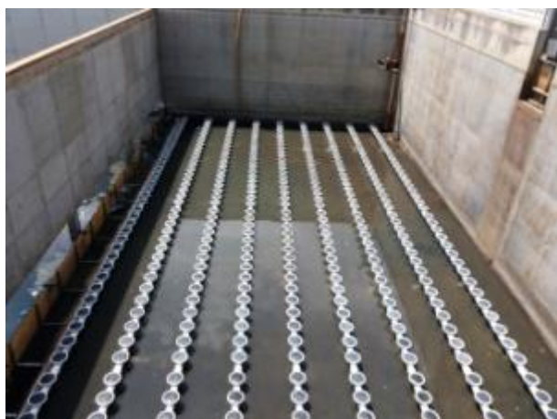
EDAR Quart - Benáger. Instal·lació de difusors en les càmeres anòxiques
