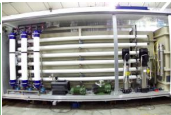
Planta pilot en fase de construcció
