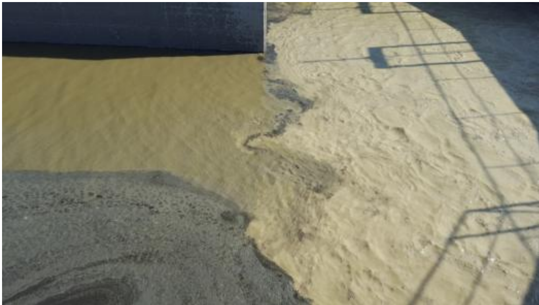
Aspecte del líquid recollit en l'EDAR Paterna Fuente del Jarro procedent d'Indukern
