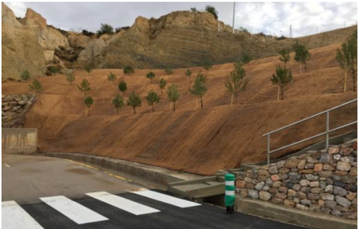
Reparació talussos EDAR Xixona
