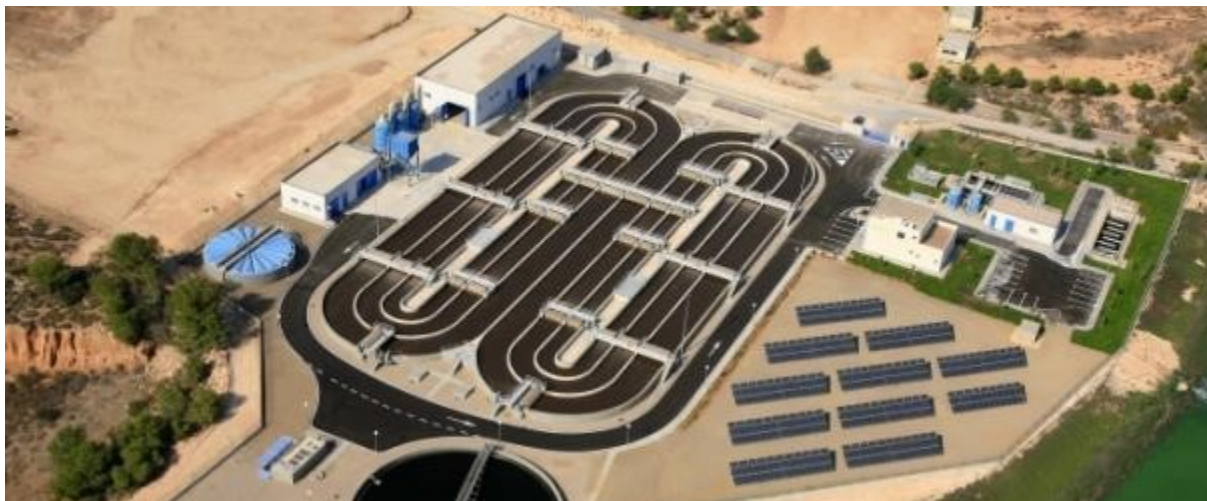
Planta fotovoltaica situada en la EDAR de Pilar de la Horadada (Alicant).
