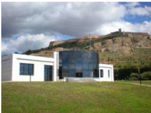
ETAP Sagunto. Edifici de control
