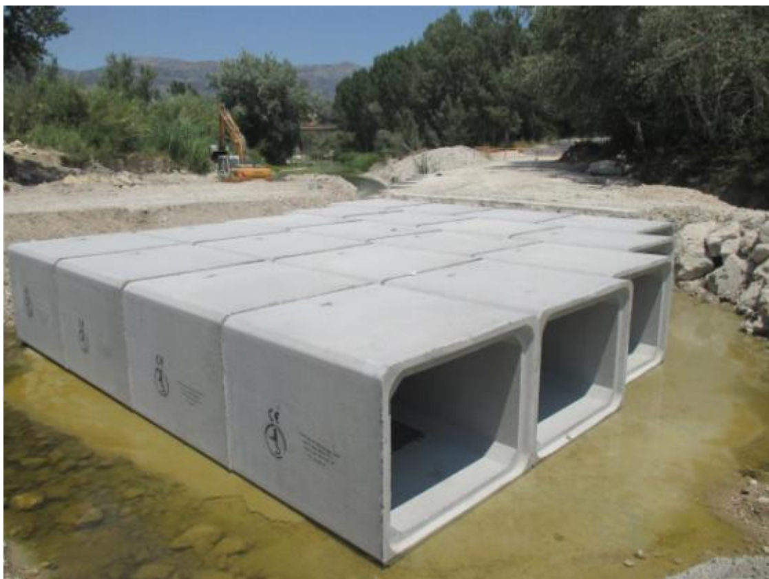
Obres d'emergència de l'EDAR de Font de la Pedra (Muro de Alcoy)
