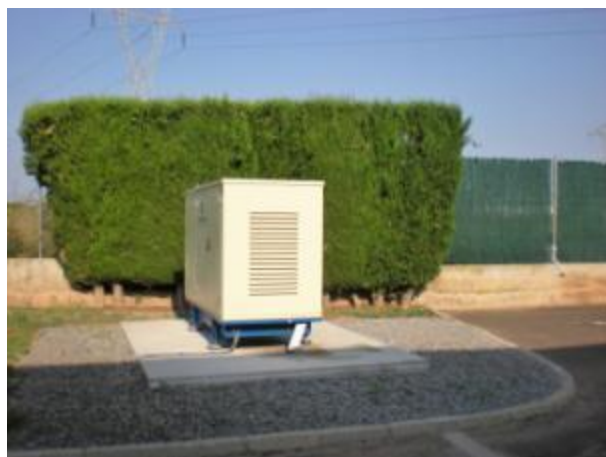
EDAR Bétera. Subministrament de grup electrògen d'emergència
