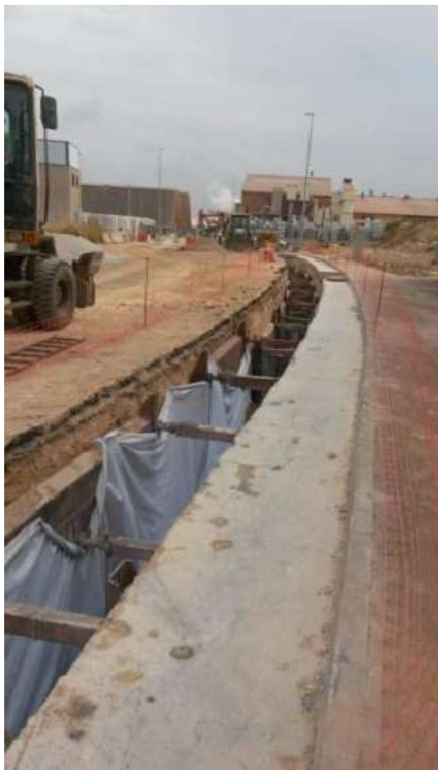
Obres reparació col·lector general Onda
