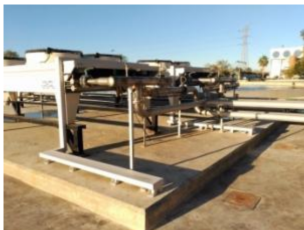
EDAR Pinedo 1. Substitució aeroventiladors
