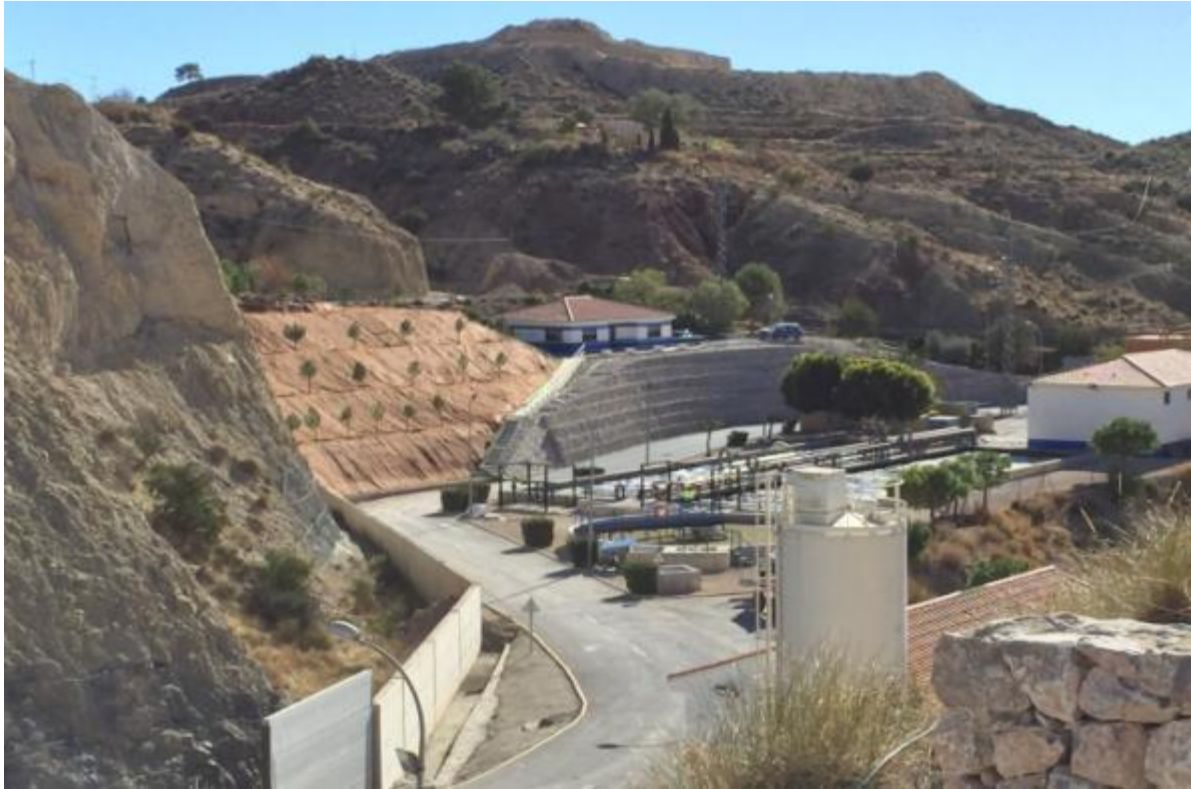
Reparació talussos EDAR Xixona
