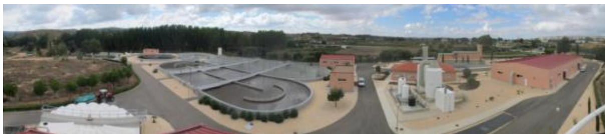
EDAR Requena. Vista general.
