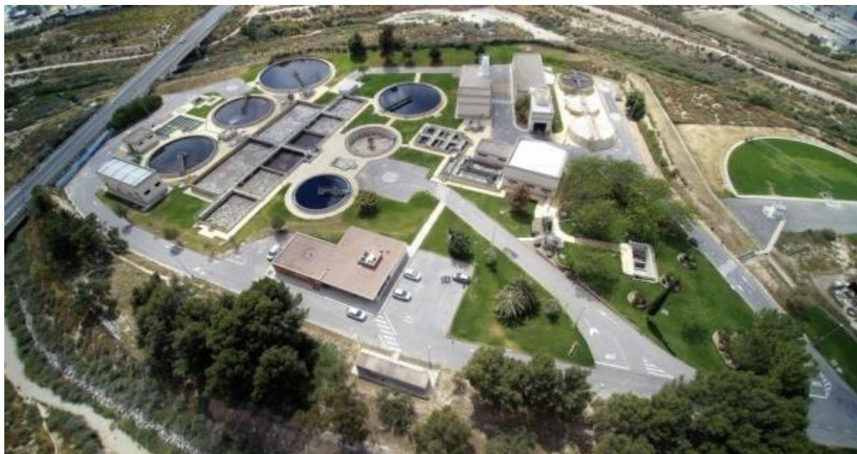
EDAR Valle del Vinalopó. Vista general.
