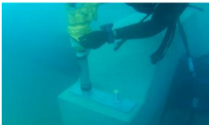
Obres d'emergència per a la reparació de l'emissari submarí d'Alcossebre
