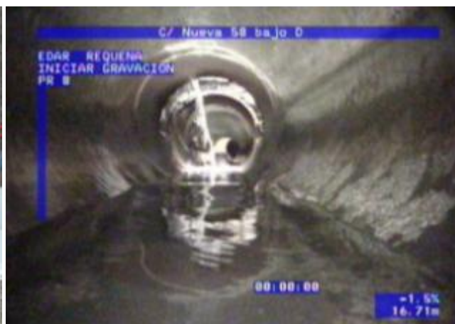
Imatge de l'interior del col·lector, feta pel robot d'inspecció
