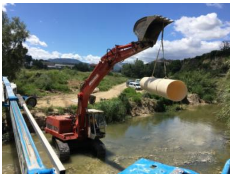
Obres d'emergència per al restabliment del col·lector general del tram 2 del sistema Font de la Pedra
