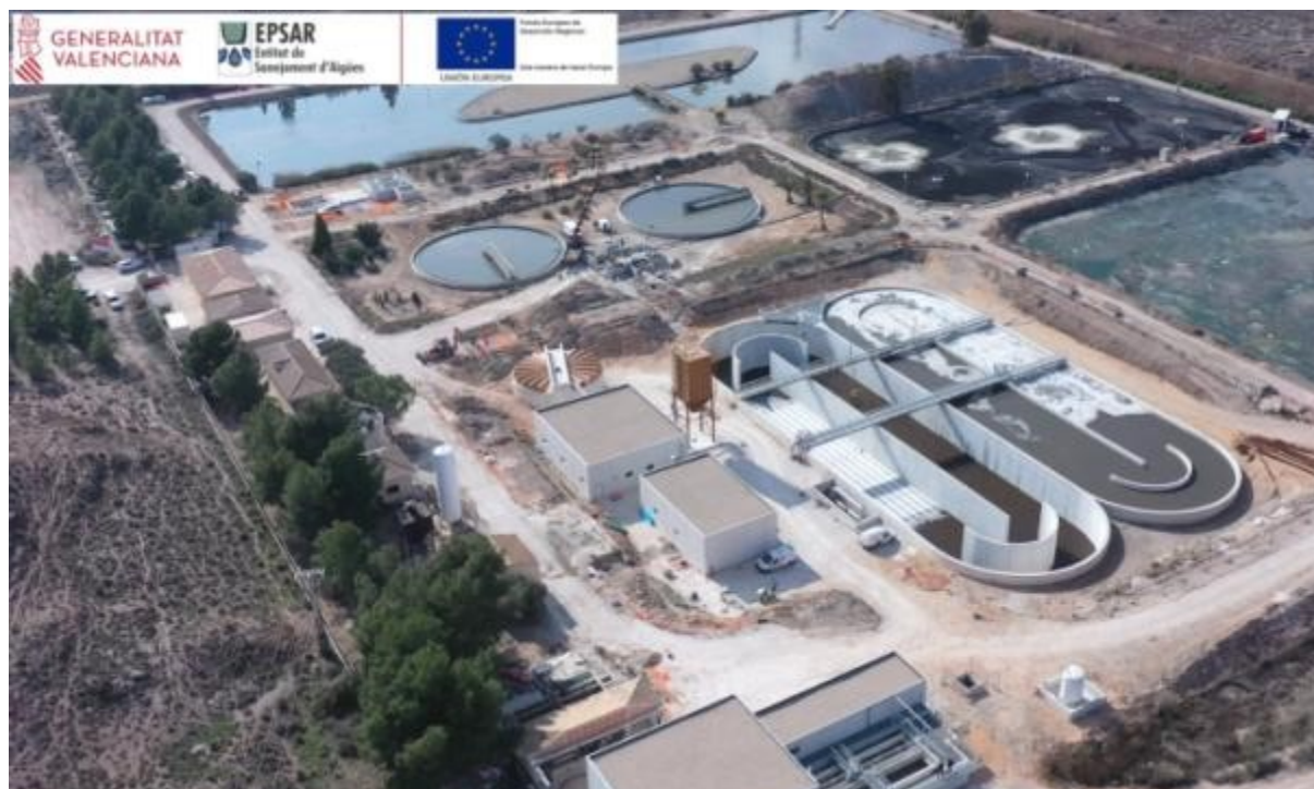
Villena. Reforma EDAR
