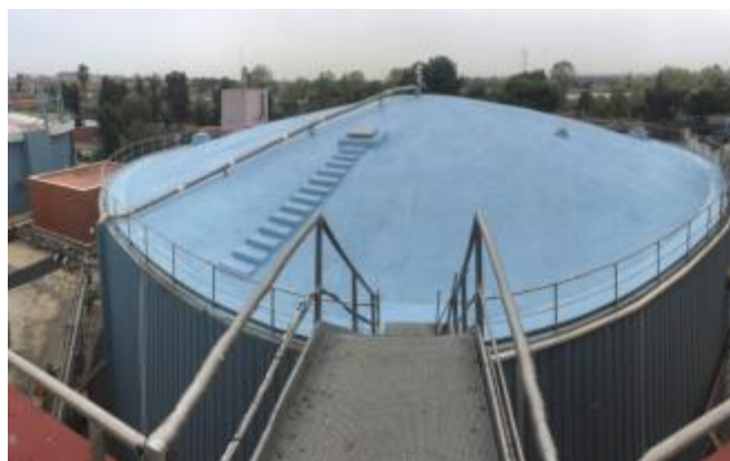
4. Reconstrucció cúpula EDAR Pinedo. Vista general de la millora
