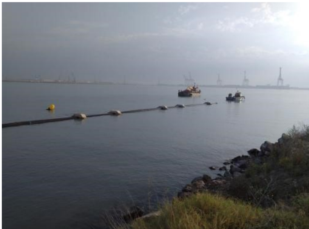
Obres d'emergència per a la reparació de l'emissari submarí de Benicàssim
