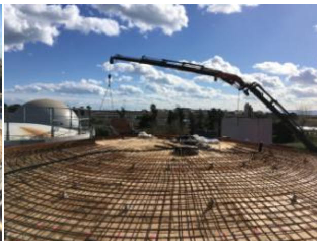
2. Reconstrucció cúpula EDAR Pinedo. Encofrat
