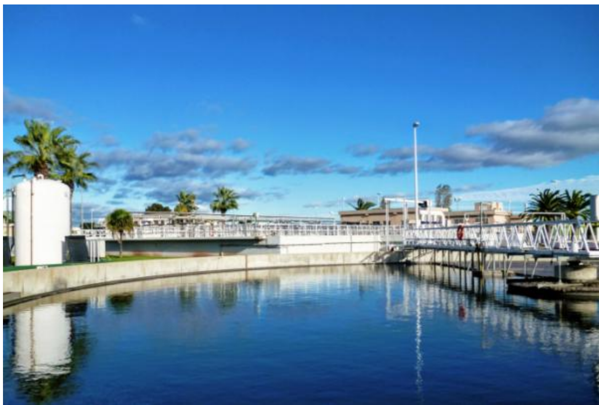
EDAR Cuenca del Carraixet. Decantador secundari
