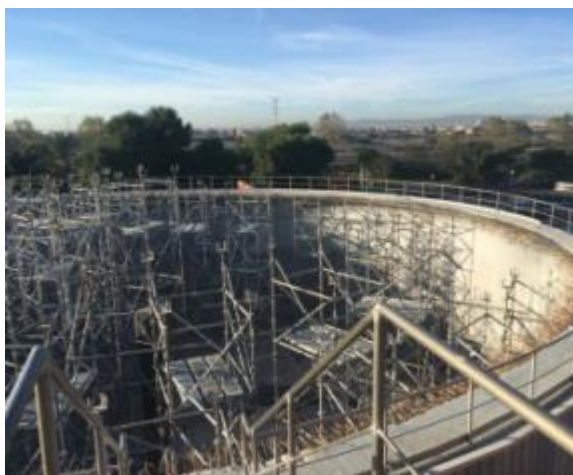
1. Reconstrucció cúpula EDAR Pinedo. Muntatge bastida
