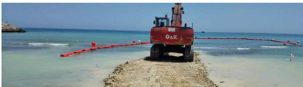
Obres d'emergència per a la reparació de l'emissari submarí de Gandia
