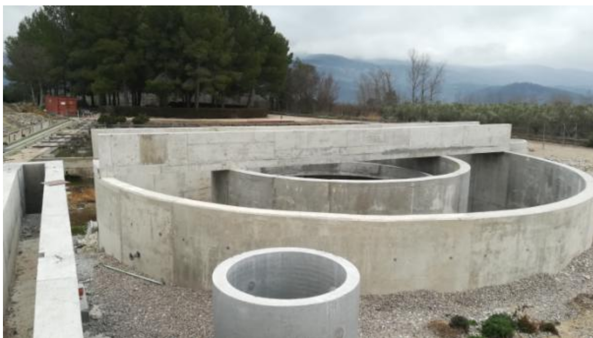
Obres de reforma de l'EDAR de Jarafuel
