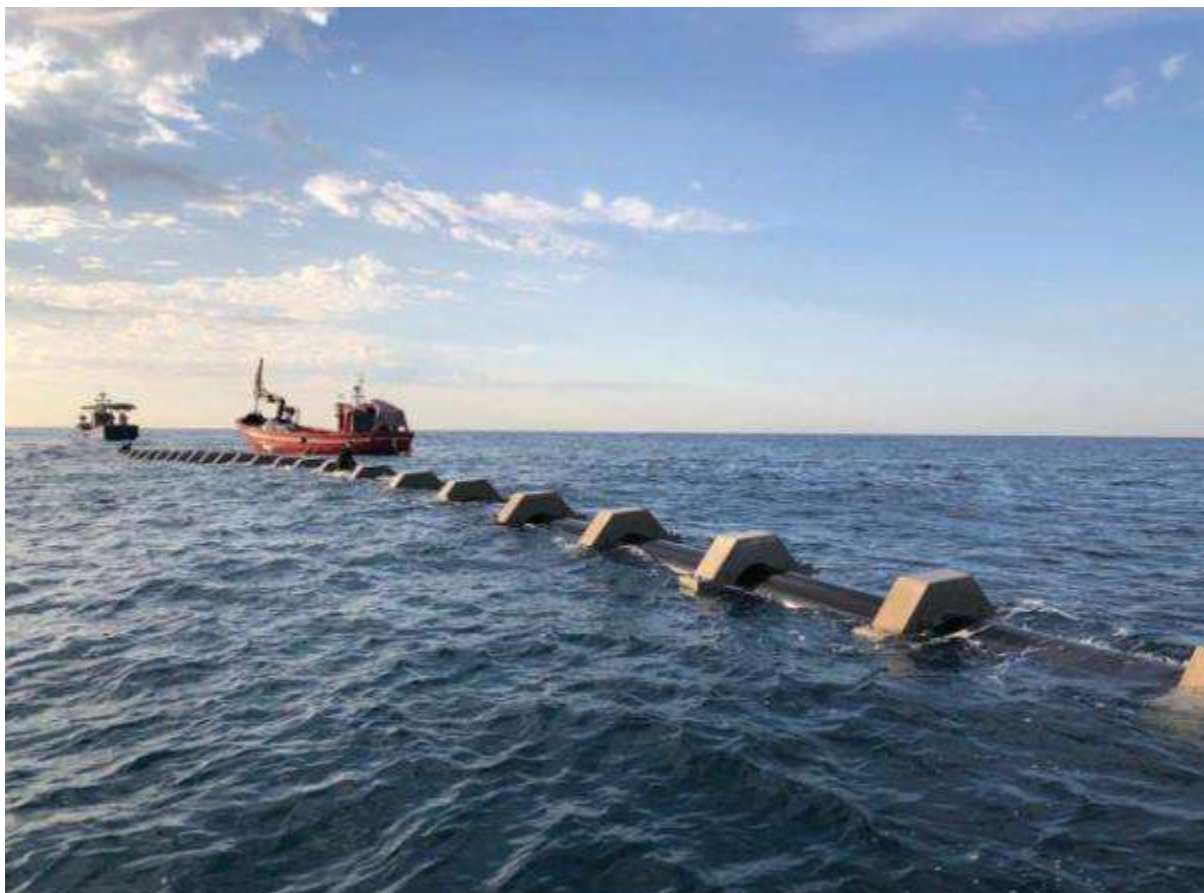
Obres d'emergència per a la reparació de l'emissari submarí de Peníscola
