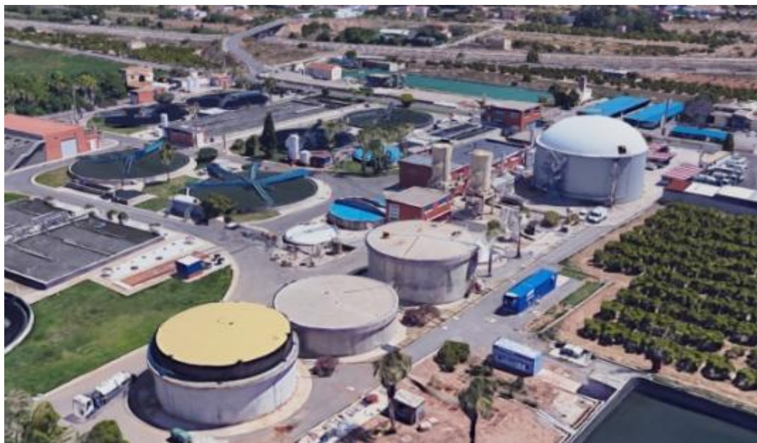
Instal·lació de digestió de llots de depuradora i subproductes industrials en l'EDAR de Castelló de la Plana
