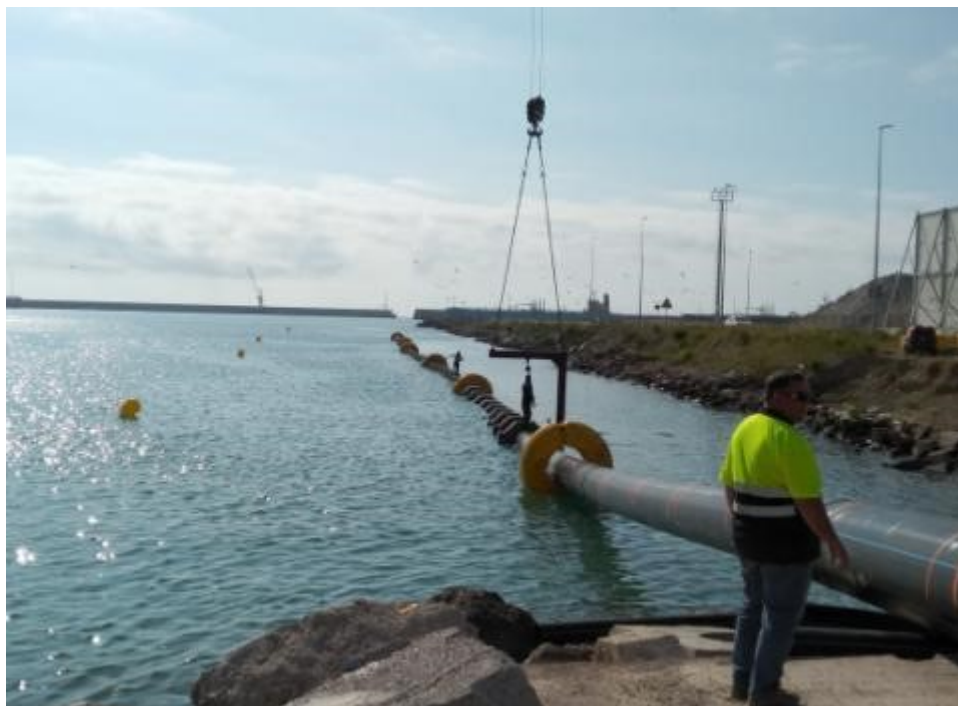
Obres d'emergència per a la reparació de l'emissari submarí d'Oropesa
