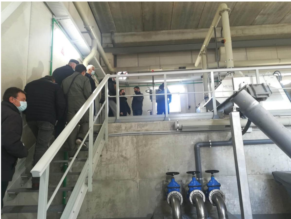
Nou edifici de pretractament
