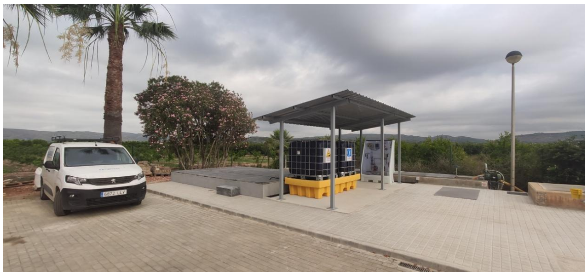
Alcàntera del Xúquer - Càrcer. Obras de construcció de un sistema de desinfecció del efluente
