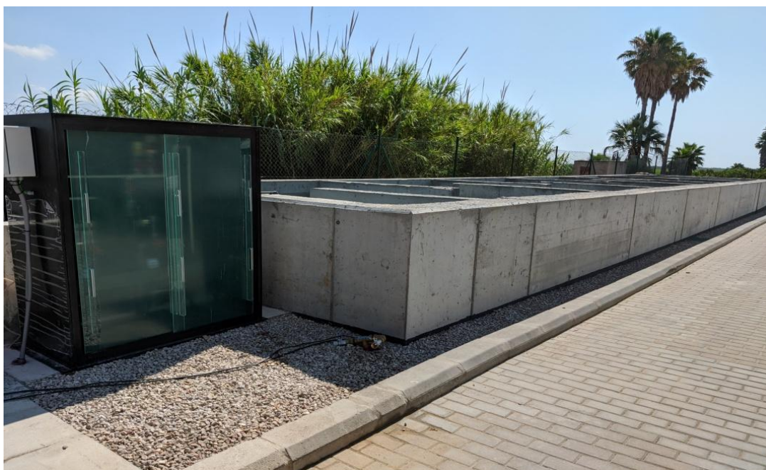
Corbera - Llaurí. Obras de construcció de un sistema de desinfecció del efluente
