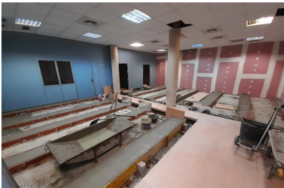
València. Adecuación del edificio de control de Pinedo II como almacén
