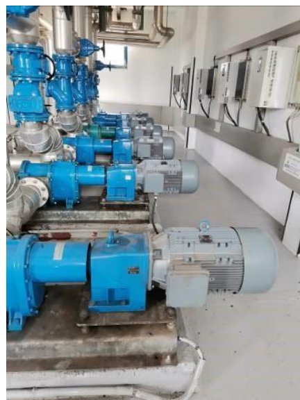
PINEDO: instalación de motores de alta eficiencia
