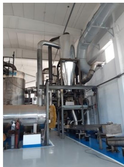
QUART-BENÀGER: Sustitución de los conos de salida de los ciclones y en el secado térmico
