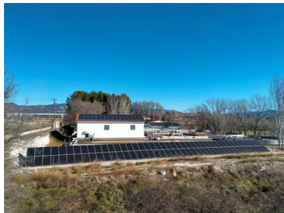
FOIA DE CASTALLA: instalación de planta solar fotovoltaica
