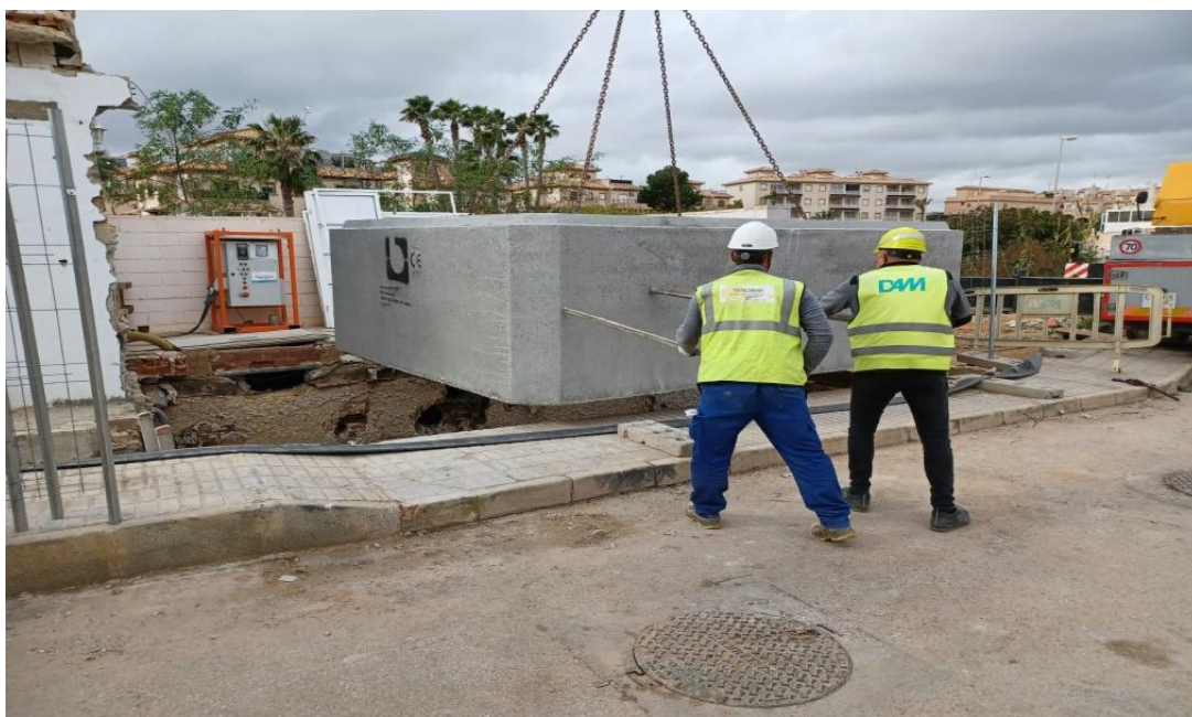
Orihuela. Obras de mejora estructural de estaciones de bombeo
