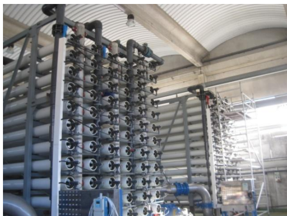
IRAD Benidorm: remodelación de la Ósmosis Inversa
