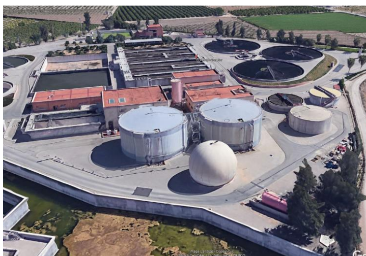
Instalación de digestión de lodos de depuradora y subproductos industriales en la EDAR de Castellón de la Plana
