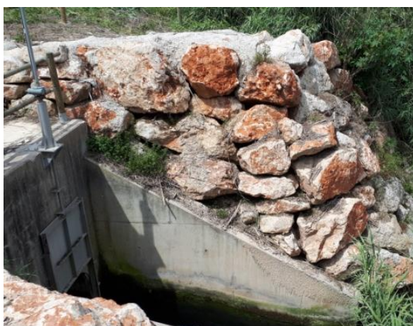
ALZIRA-CARCAIXENT: acondicionamiento de la obra civil de vertido a cauce del río Júcar
