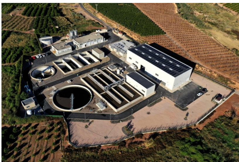
EDAR de Bétera.
