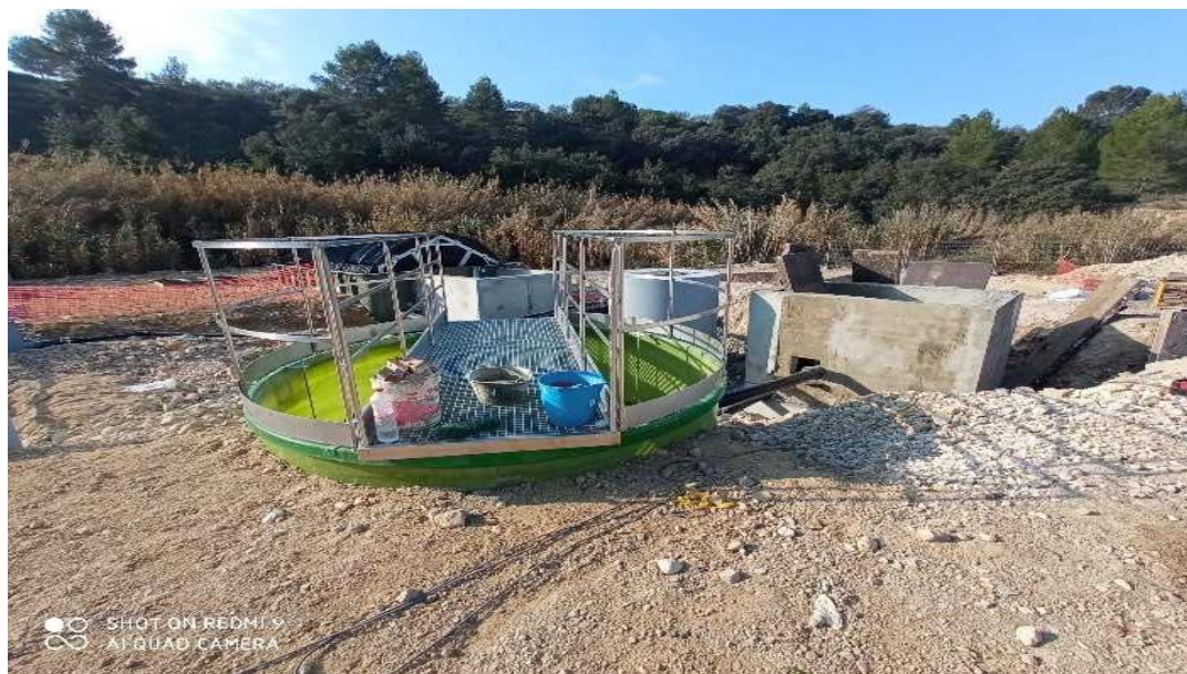
Beniatjar. Obras de construcción de nueva EDAR
