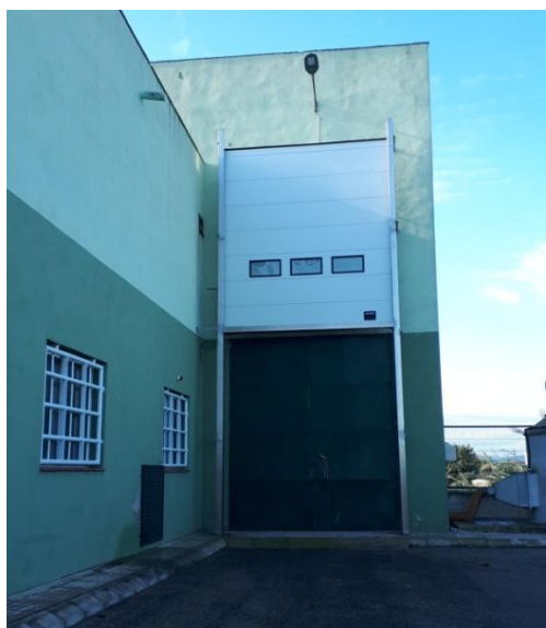
ALCUDIA – BENIMODO: mejora en infraestructuras de la EDAR
