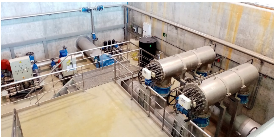
Estación Regeneradora de Agua en la EDAR de Alacanti Norte Q=30.000 \text{ m}^3/\text{d} (proceso de desinfección por UV)
