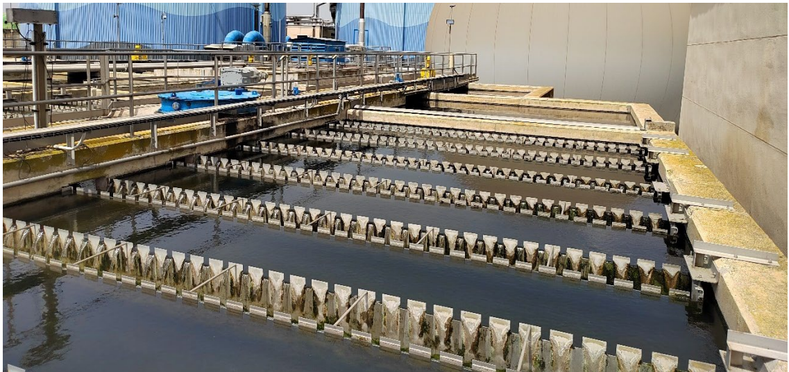
Estación Regeneradora de Agua en la EDAR de Pinedo Q=350.000 \text{ m}^3/\text{d} (proceso de decantación lastrada)
