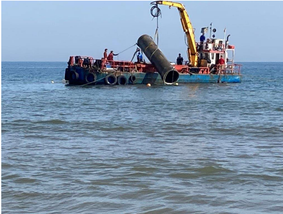
València. Obra de emergencia aliviadero submarino acequia de Vera.
