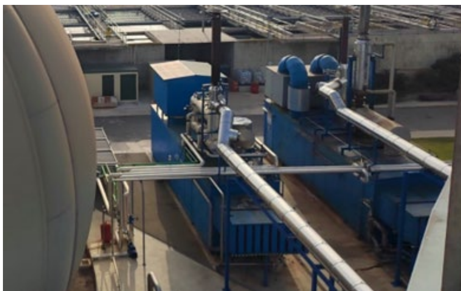
EDAR Pinedo 2. Motores de cogeneración de 2.589 kW.
