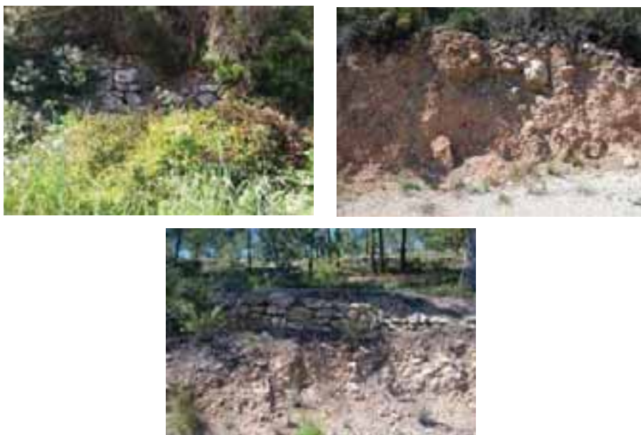
Figura 100 Muros de piedra en seco en la parte del camino de dentro del complejo educativo
