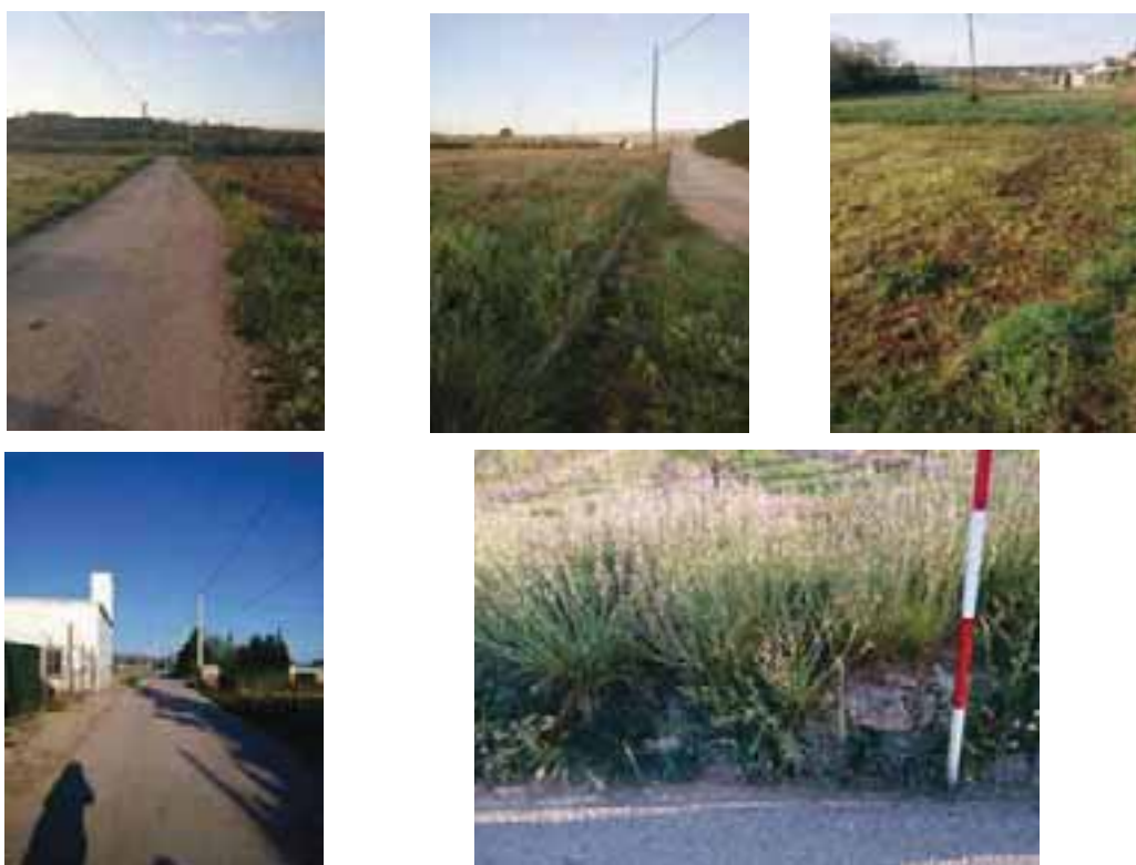
Figura 57 Camino asfaltado con los campos delimitados con muros de piedra
