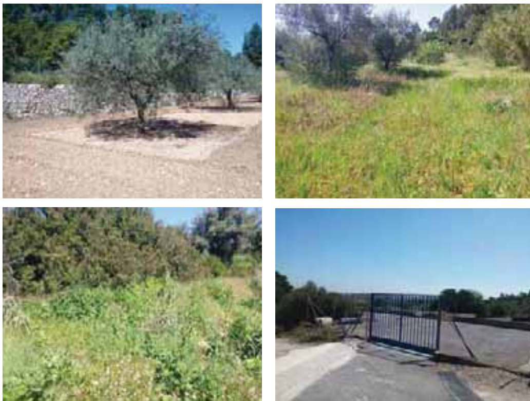
Figura 96 Campo de olivos, campos con abundante vegetación de altura y entrada a EBAR
