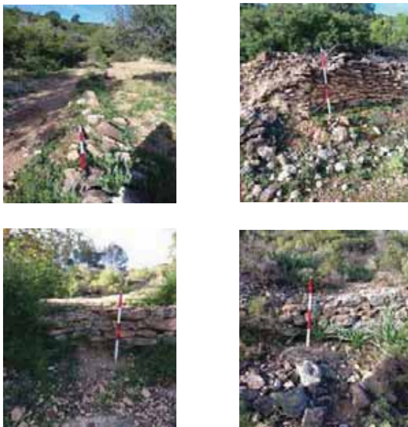
Figura 16 Alineación de piedras y muros de piedra en seco
