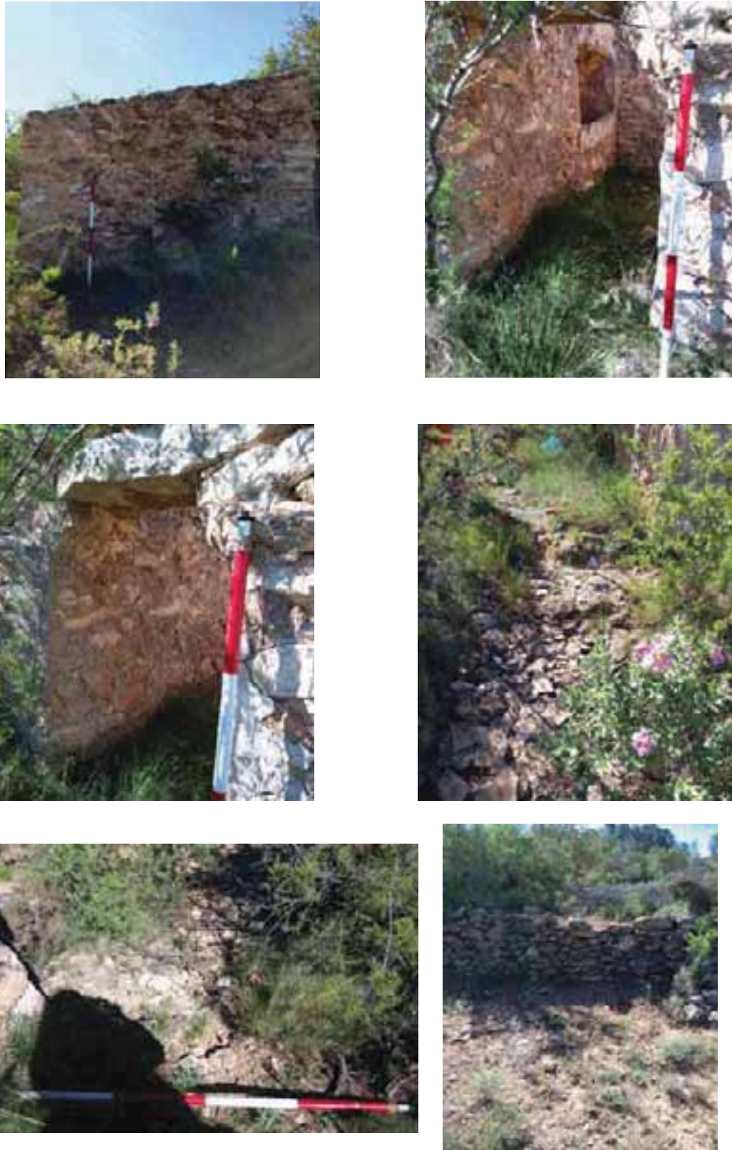
Figura 8 Muros de piedra en seco y caseta de aperos
