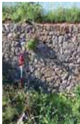
Figura 2 Muros de piedra en seco
