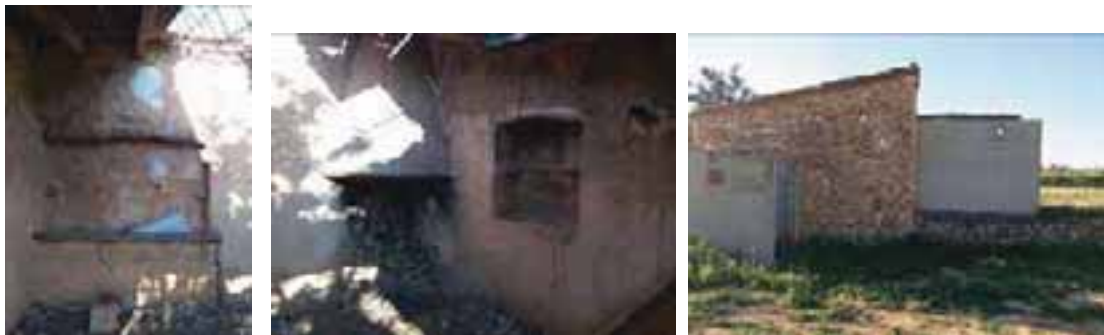
Figura 120 Vista interior y exterior de la Caseta de aperos con Corralillo, Partida la Sechara 01
