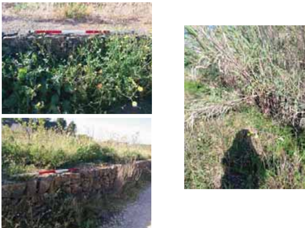
Figura 66 Muros de piedra en seco
