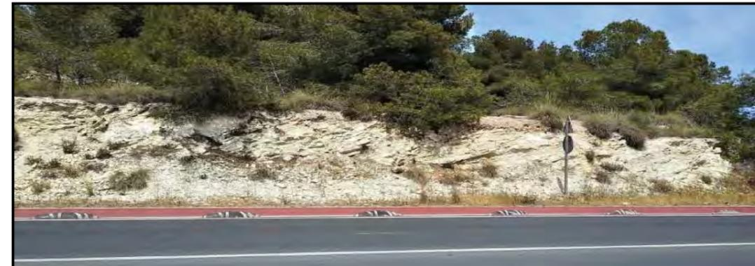
Roca caliza estratificada en delgadas capas, con menos de 20 centímetros de espesor. Colector Cautivador Este.
