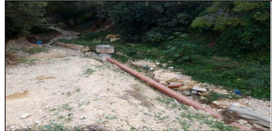
Un ejemplo de lo que puede llegar a ser esta problemática es un caso ocurrido en el ramal del Romeral, más precisamente el tramo que circula por el barranco de Barceló, por el cual tras una lluvia intensa parte del trazado se rompió realizando **vertidos de aguas residuales** al entorno medioambiental, tal cual se puede apreciar en las siguientes dos imágenes:
