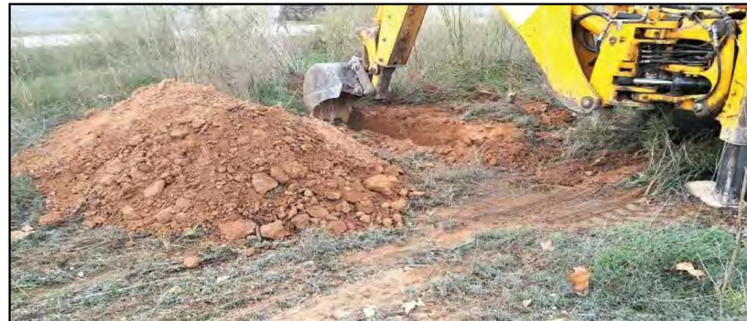
Unidad A2. Colector Oeste, limos excavables con facilidad.
