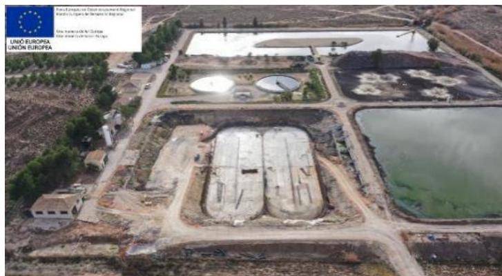
Villena. Reforma EDAR
