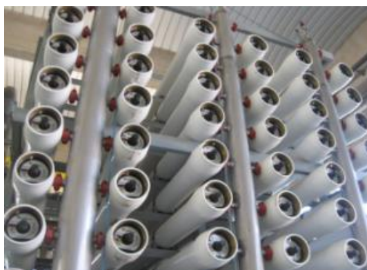
IRAD Benidorm. Membranas de ósmosis inversa
