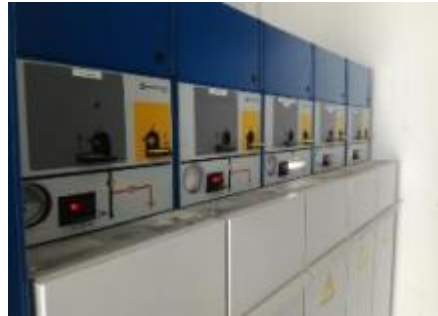
EDAR Pinedo. Celdas del nuevo anillo interno de suministro en media tensión
