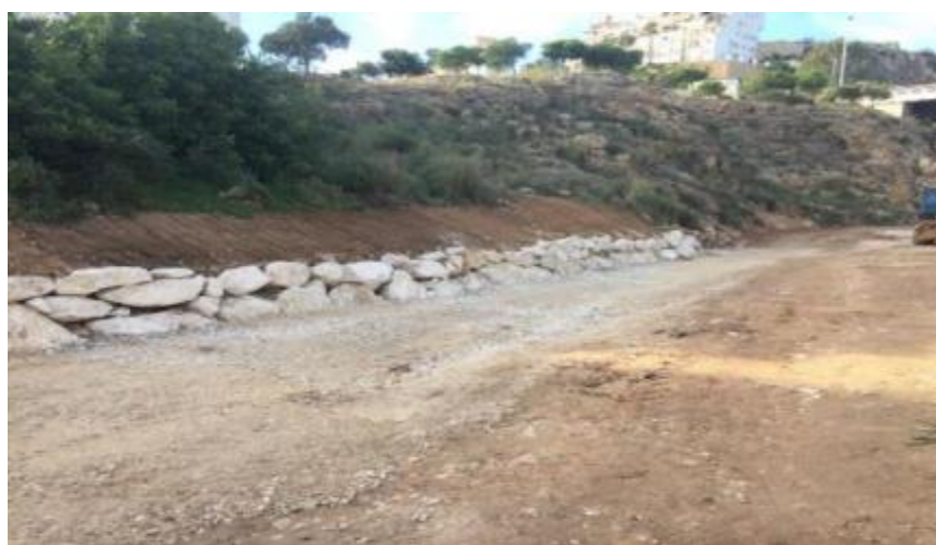
Santa Pola. Obra emergencia
