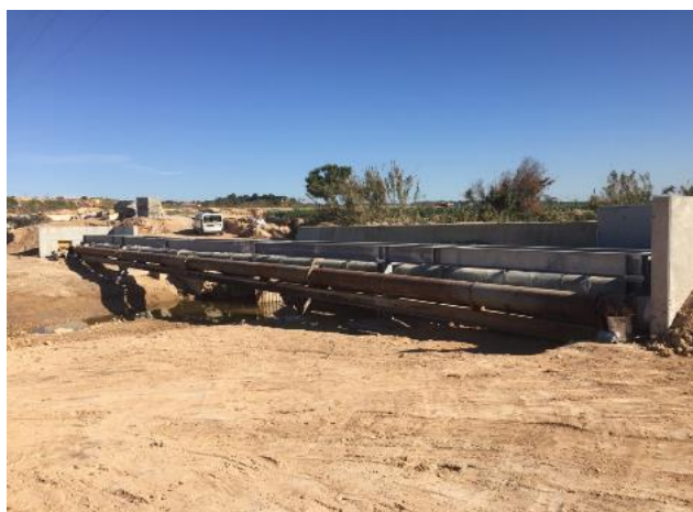
Pilar de la Horadada. Obra de emergencia
