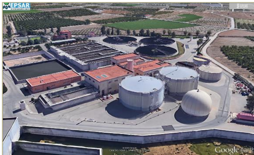
Instalación de digestión de lodos de depuradora y subproductos industriales en la EDAR Albufera Sur
