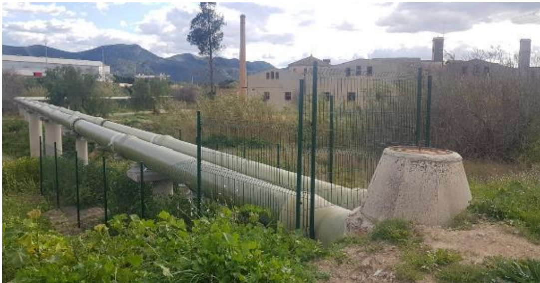
Canals. Obras de sustitución de tramos aéreos
