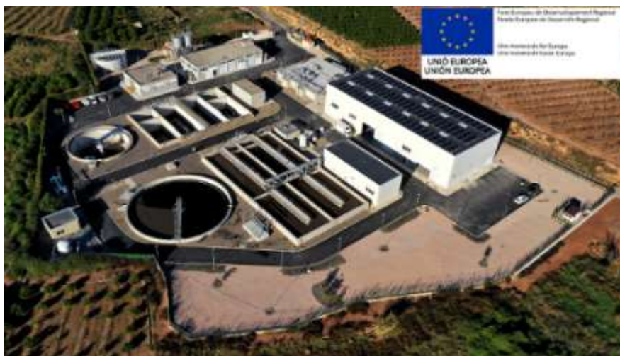
Bétera. Obras de ampliación
