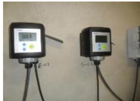
EDAR Oropesa del Mar. Instalación de medidores de SH 2
