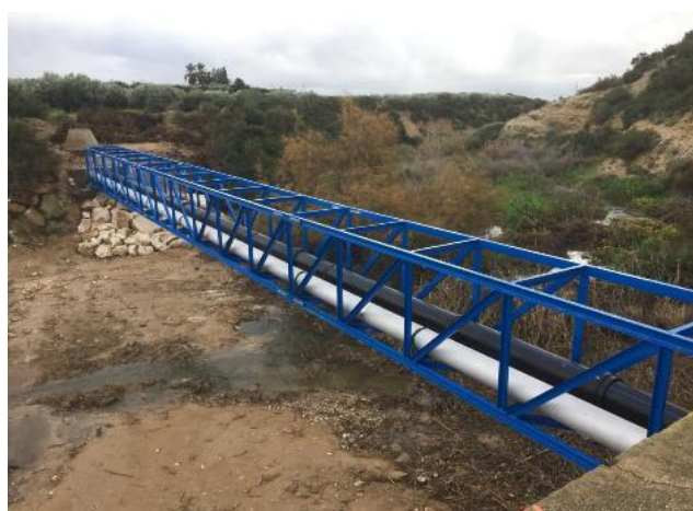
Crevillent. Obra de emergencia
