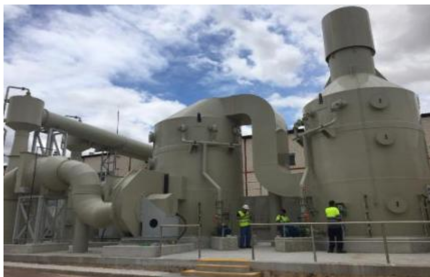
Aspe. Reparación de instalaciones de desodorización
