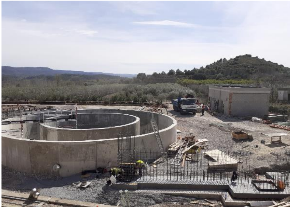
Jarafuel. Obras de reforma
