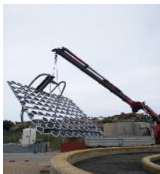
EDAR Aiello de Malferit. Sustitución de parrilla de difusores
