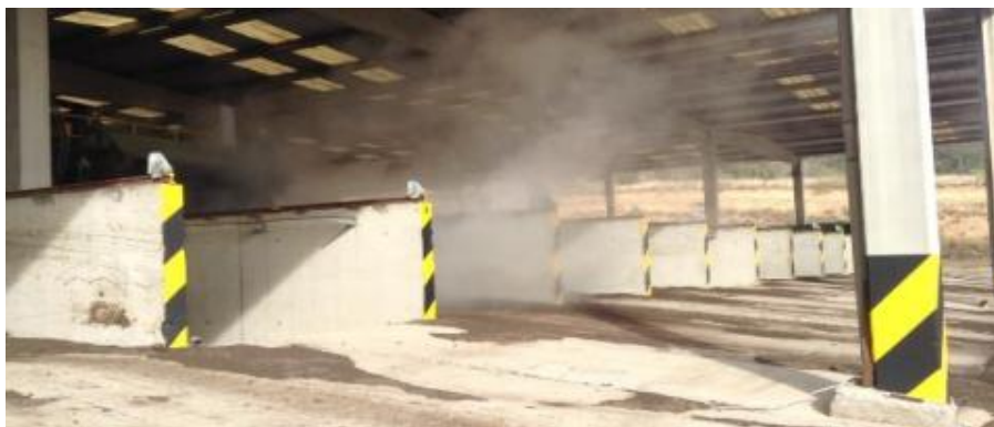
Canales de compostaje de lodos de Calles
