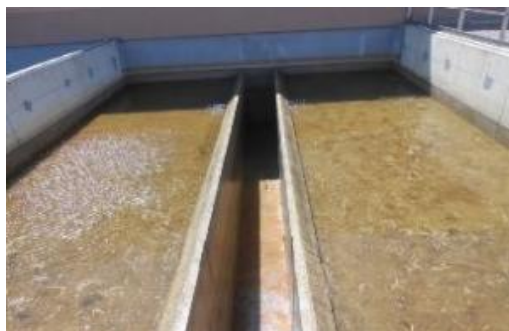
EDAR Quart - Benáger. Filtros de arena
