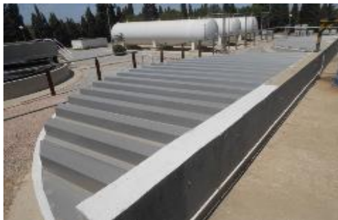
EDAR Quart - Benàger. Sustitución de cubiertas de los espesadores
